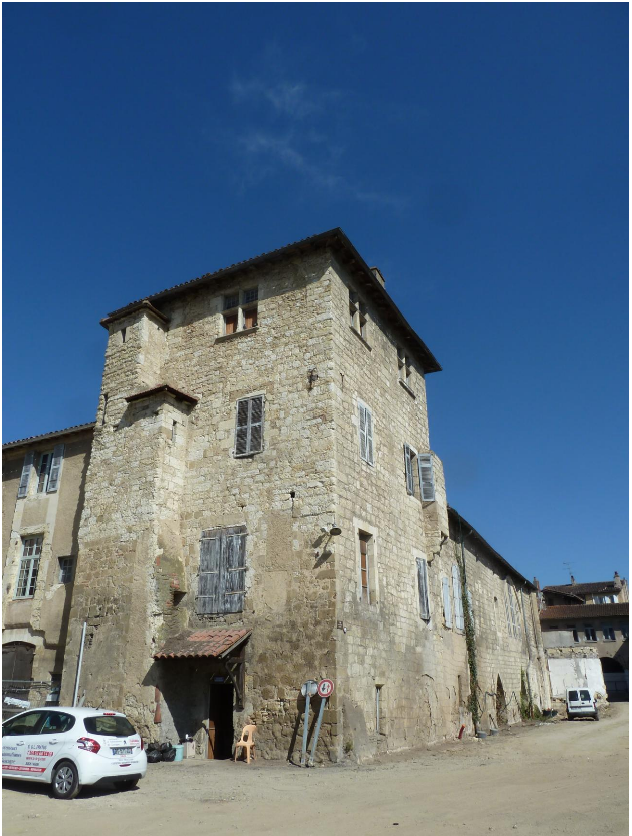
Fig. 15 : Auch, ancien prieuré Saint-Orens, « la tour du prieuré », depuis le sud-est (Cliché C. Balagna).
