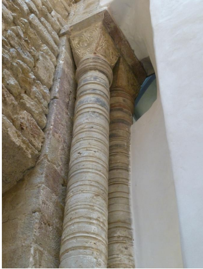
Fig. 9 : Saramon, ancienne abbatale, la tour Saint-Victor, détail de l'élevation intérieure côté sud.
