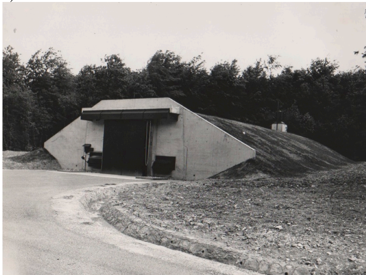
Figure 7 : un abri Stradley neuf et recouvert de terre mais non encore engazonné sur un espace issu du déboisement au dépôt du Rozelier à Verdun. Collection capitaine Baudelot.
