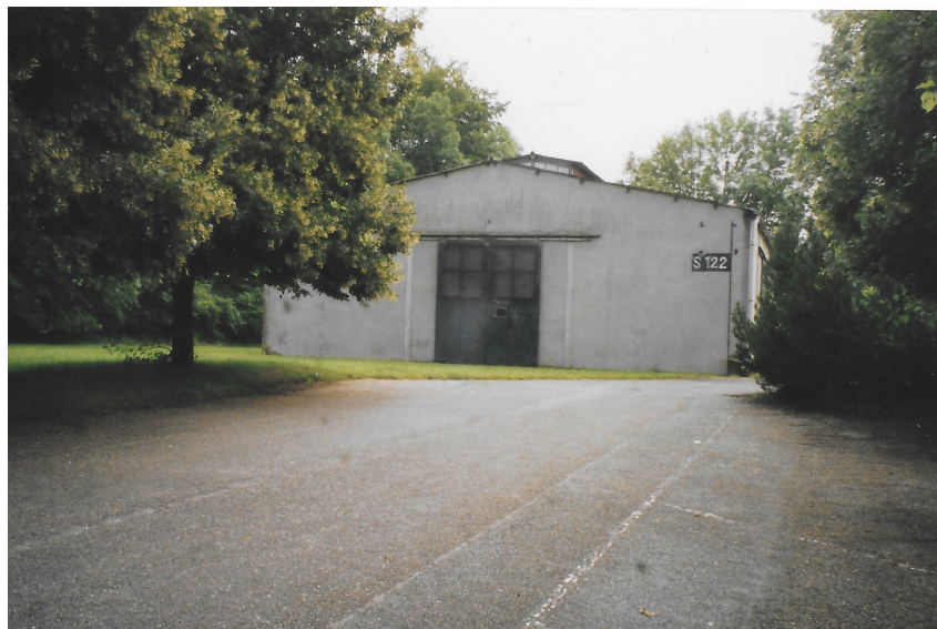
Figure 3 : un des nombreux entrepôts créés dans la forêt et une aire issue d'un déboisement. Photographie P. Labrude, 2007.
