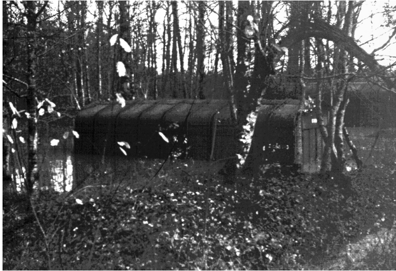
Figure 4 : un bâtiment métallique Fillod à Trois-Fontaines. Collection J.-P. Frêche.
