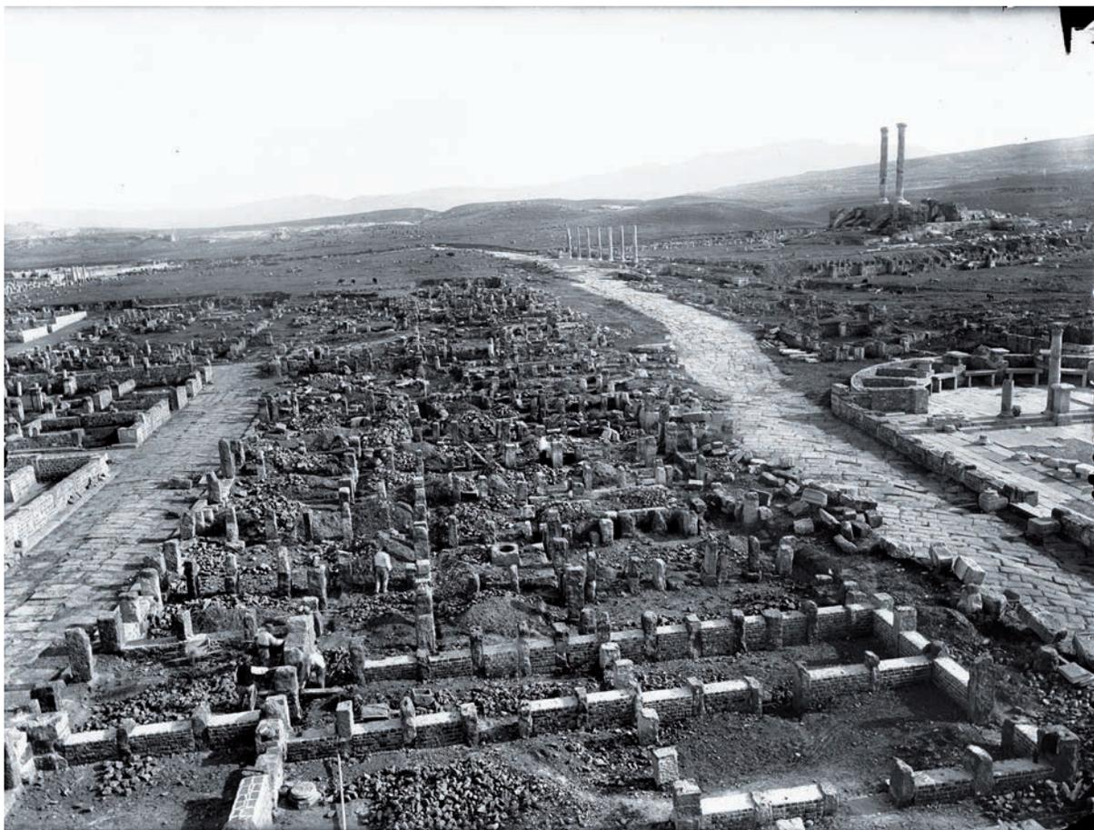
Fig. 4-5 : Timgad, « Bande sud-ouest » : avant/après, un exemple de la destruction et du remontage systématique artificiel des murs en pierre et probablement aussi composés de terre (A. Ballu, clichés APBLL00213P et APBLL00008N, ministère de la Culture, Médiathèque de l'architecture et du patrimoine, Dist RMN-GP).
