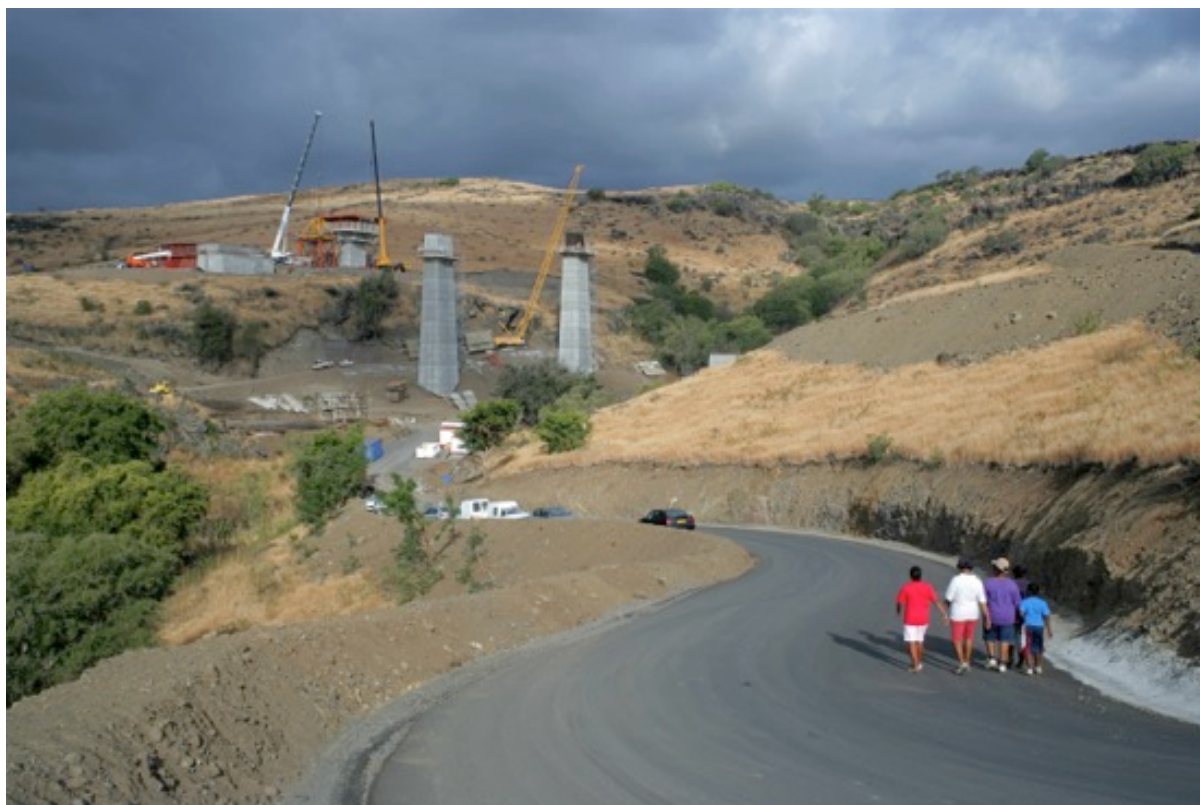
Image 11 : Promeneurs sur le chantier de la route des Tamarins au Cap La Houssaye. © Hervé Douris, 22 septembre 2005.
