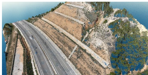
Figura 4 Nube de puntos del talud de estudio generada con un dron con cámara RGB, aplicando técnicas de fotogrametría
