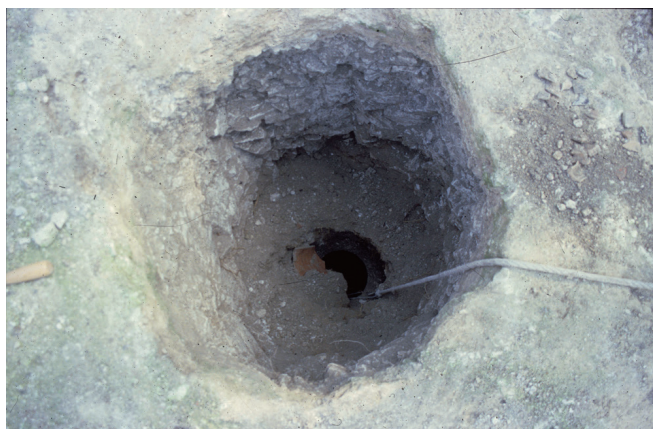
Fig. 5a. Vue zénithale de l'ouverture obstruée du puits de la rue de Cernay (cl. Ph. Rollet).
