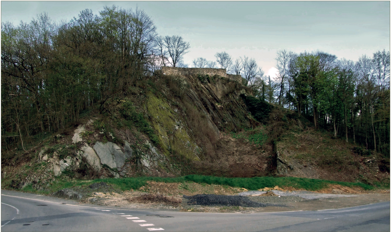
Fig. 2.68 – Vue générale du château depuis l'ouest. On distingue la maçonnerie d'angle (UC 6.4) dans le bas de la pente droite.
