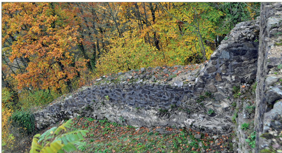
Fig. 2.48 – Vue générale de l'enceinte, parement côté cour (UC 2.6). La limite entre bâti ancien et remontage récent.
