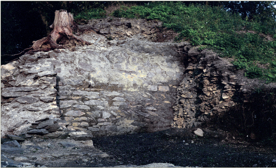
Fig. 2.43 – Les parties hautes de l'élévation nord-est (UC 1.1) de l'aula possédaient encore un enduit partiel (UC 1.16) lors de leur mise au jour, 1990.
