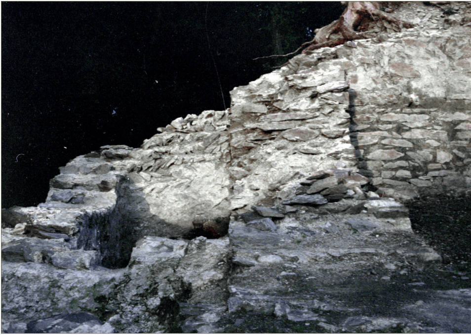
Fig. 2.57 – Pièce A. Parement nord-est (UC 3.1) en épi.
