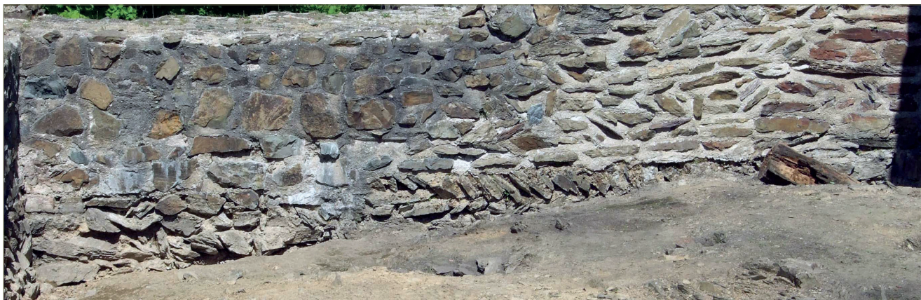
Fig. 2.39 – Maçonnerie partiellement en épi, mur nord-ouest (UC 1.2) de l'aula.
