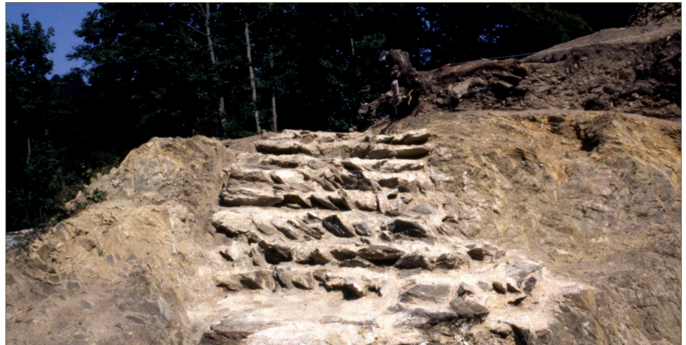
Fig. 2.44 – Blocage en épi (UC 1.11) bien visible au niveau des fondations de l'aula, 1991.
