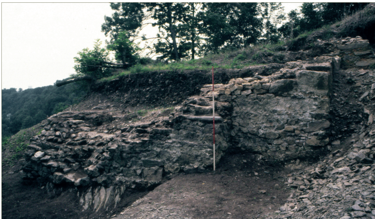
Fig. 2.66 – Élévations externes sud-est des pièces B et C (UC 4.6 et 5.5). On remarque le blocage en épi de la pièce B, 1988.
