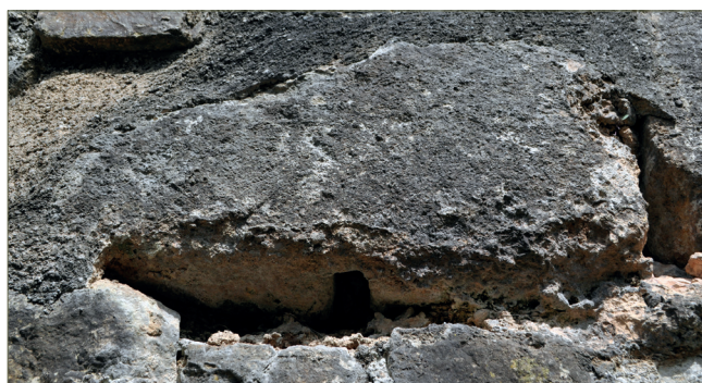
Fig. 2.64 – Pierre gallo-romaine en remploi (UC 5.6). On distingue le logement d'une agrafe.
