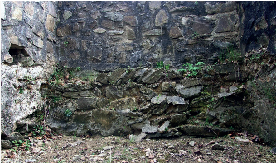
Fig. 2.37 – Fondation et base extérieure du mur nord-ouest (UC 1.6) de l'aula.
