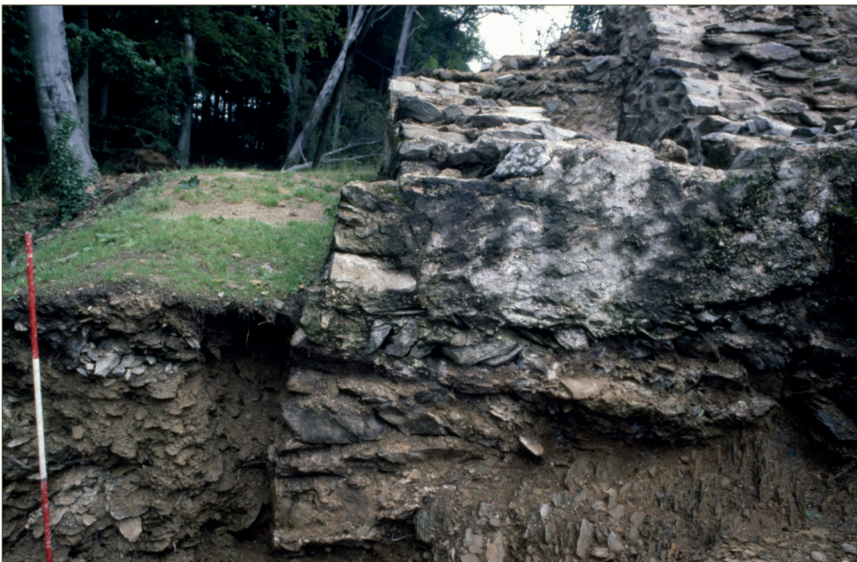
Fig. 2.59 – Élévation sud-ouest de la pièce A (UC 3.3). On remarque le pendage vertical de la roche sur laquelle elle est fondée.
