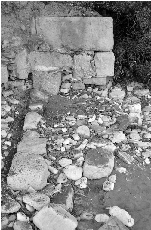
Figure 5 : mur Pb, parement sud, avec le prolongement de sa fondation en jetée. Vers le nord.
