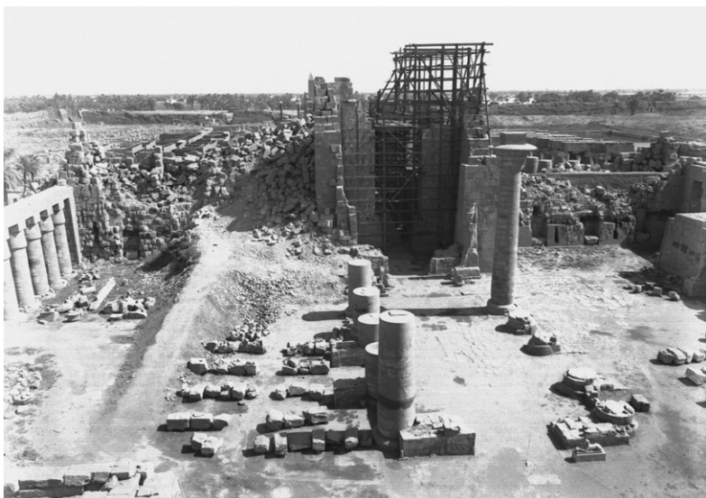
FIG. 11. Vue de la façade ouest du môle nord entre les travaux de G. Legrain et ceux de H. Chevrier.
