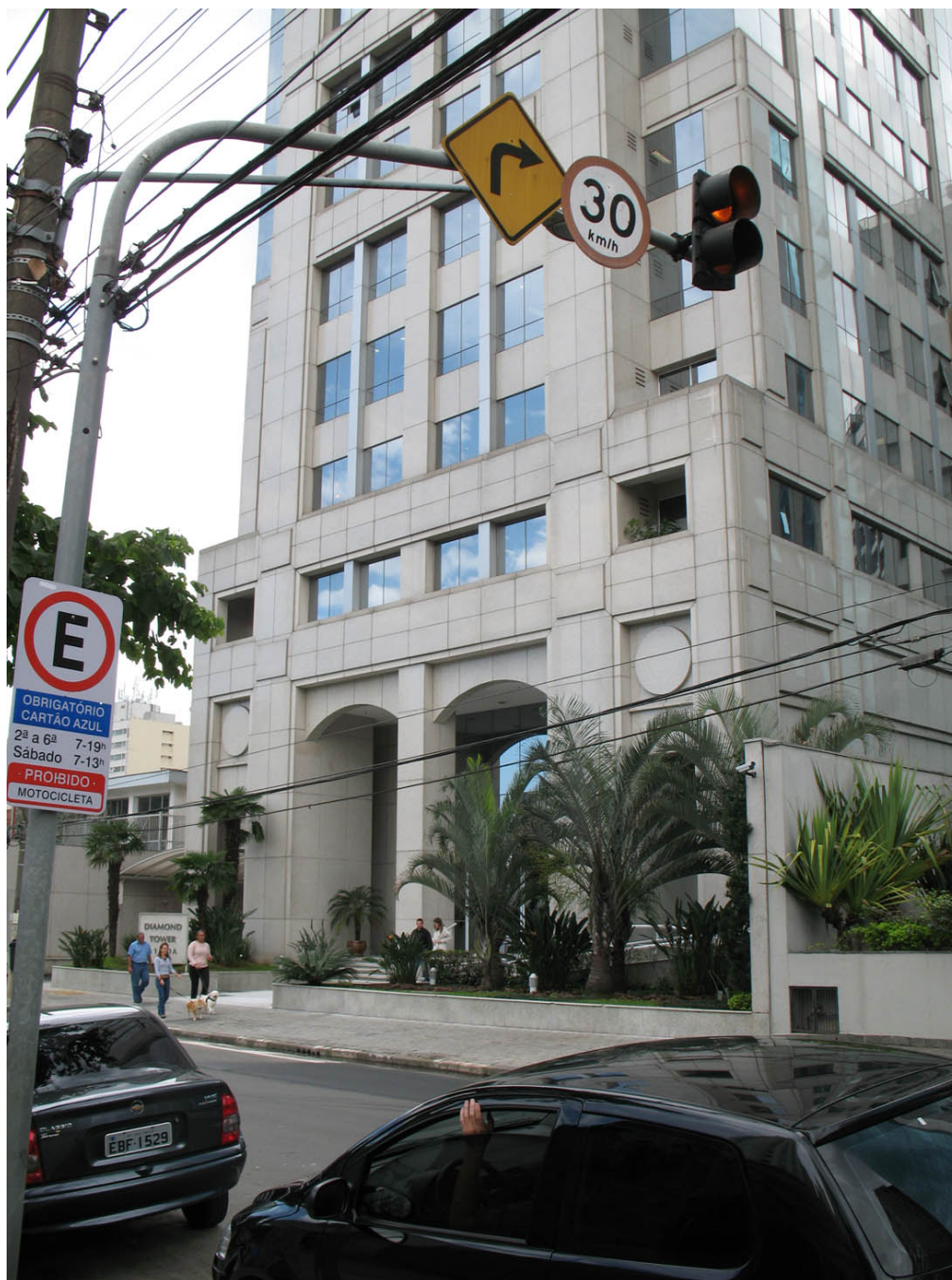
Les bureaux de la filiale Boiron Brésil sont installés à l'un des étages de cet immeuble (Quartier d'Itaim Bibi, São Paulo) Armelle Giglio-Jacquemot, 25 août 2009
