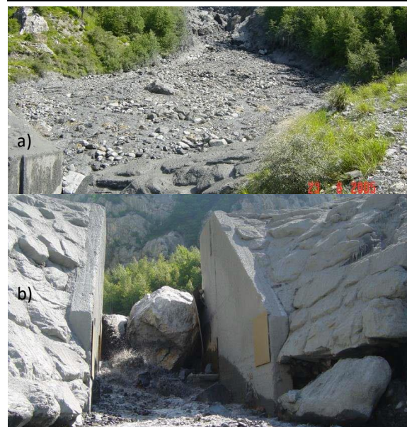
Fig. 4: Dépôt après la lave torrentielle du 22 juin 2005 : a) dépôt d'aspect assez granulaire remplissant presque le bassin et b) fente presque bloquée par deux gros blocs
