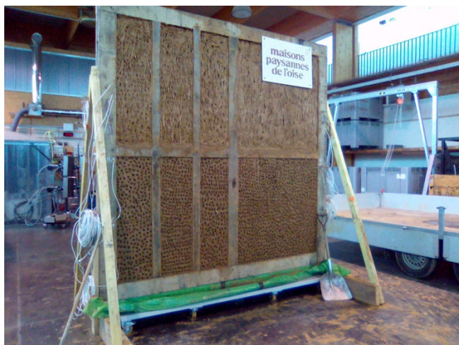
Fig. 1 : Montage du mur à colombages sur site pour la mise en place des sondes
