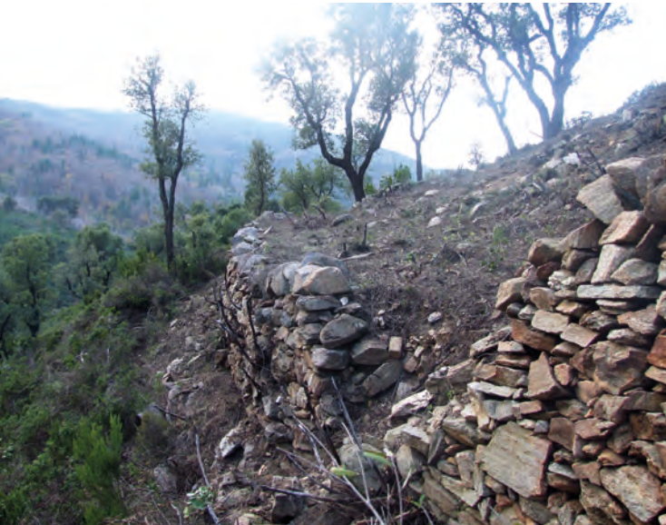
Photo 5 (à gauche). Mur inférieur surmonté de pierres posées de chant (photo L. Boudinot).
