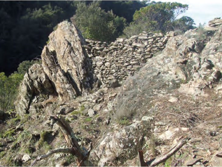
Photo 11. Brèche de la roche comblée par un mur en pierre sèche (photo L. Boudinot).
