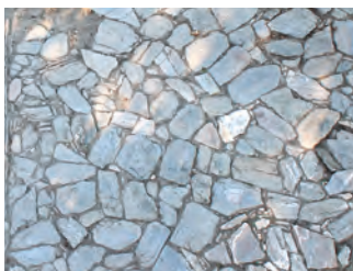
Etude d'une aire à blé avant sa destruction
