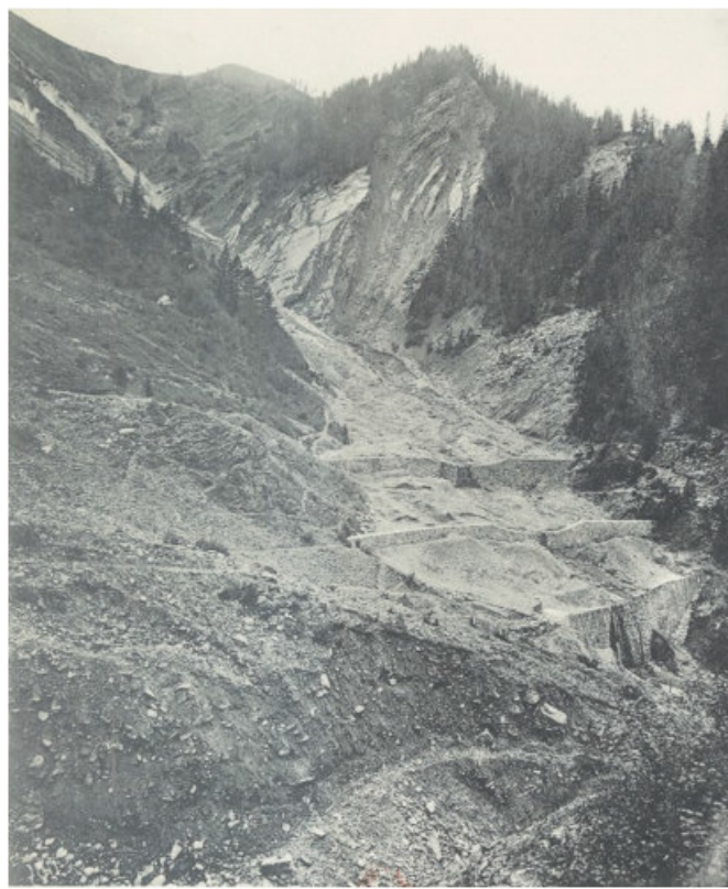
Figure 5 : Barrages de rétention des dépôts morainiques issues des têtes de bassins : Ravin des Arandellys, affluent de la Griez qui se jettent dans l'Arve en aval du barrage EDF des Houches (74) (source : Eaux et Forêts 1911 [20])
