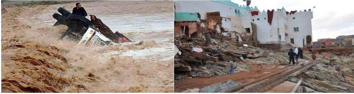
Photo 1. Effet des inondations du 22 novembre 2014 à la ville d'Agadir. (Source : http://ar.le360.ma )
