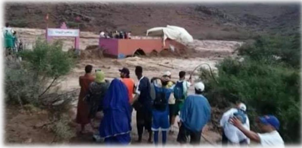
Figure 6. Dommages causés par des inondations, région de Taroudant, 2019
