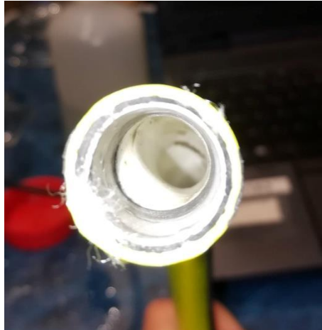
Figure 21 : Photo montrant l'intérieur d'un tuyau
