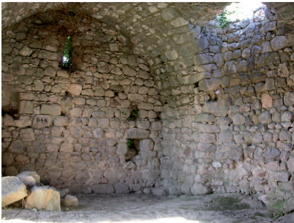
Photos 3 et 3. Salle du rez-de-chaussée de la tour, ses fenêtres à ébrasement et ses placards muraux.
