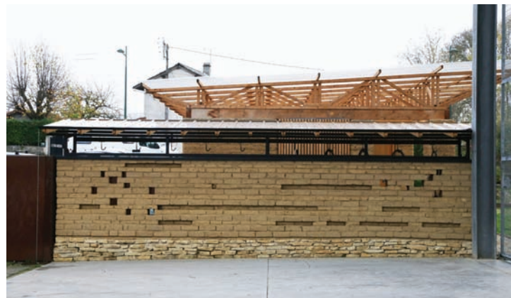
Fig. 2 Abri à vélo résultat de l'atelier « Jeux d'adobes » autour de l'exploration de la brique de terre crue, photo : amàco
