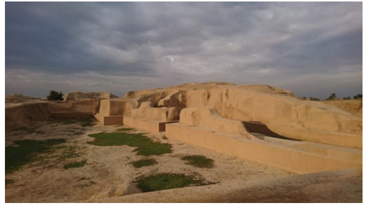
Fig. 6 Principe mixte de conservation préventive et de restauration partielle des bases de murs sur le site élamite de Haft Tappeh en Iran, photo : CRAterre, D. Gandreau, 2017
