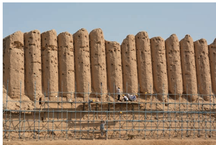
Fig.2 Secteur protégé par une couverture à Sarazm, Tadjikistan, photo : D. Gandreau, 2012
