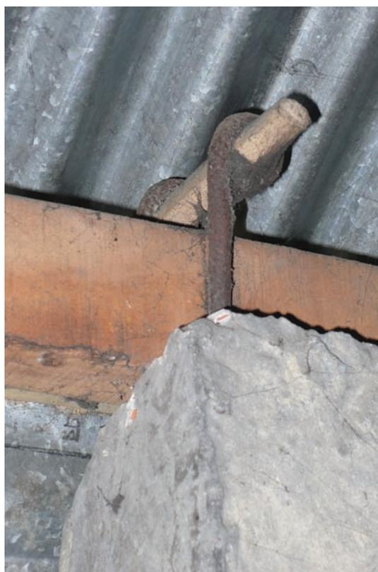
Fig. 3 connexions pour un démontage rapide
