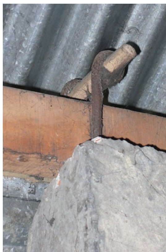
Fig. 3 connexions pour un démontage rapide
