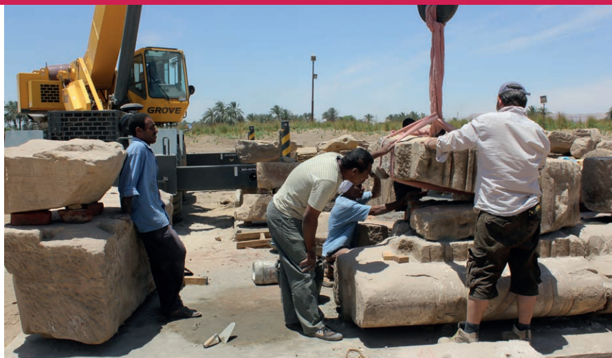
Figure 8. Un chantier de remontage à Médamoud. L'installation d'un bloc nécessite deux opérateurs : le grutier assure le déplacement du bloc dans l'espace, tandis que le tailleur de pierre, posté devant le lieu de pose, agit manuellement sur sa rotation et son éventuelle inclinaison.
