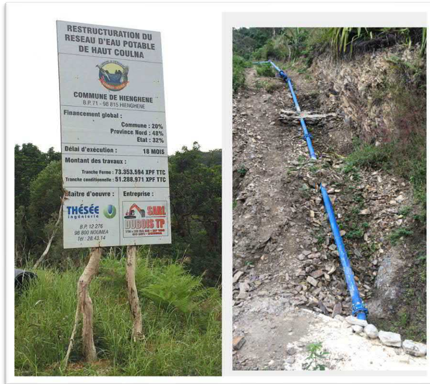
Figure 17 : Photos des travaux d'installation du nouveau captage de Haut-Coulna (Coulange, Haut-Coulna, 05/06/2019)
