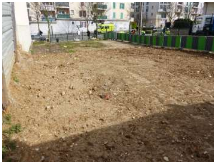
FIGURE 15 : VUE DEPUIS L'OUEST DE LA PARCELLE (A DROITE, VERS LE SUD, LES TRAVAUX DE VOIRIE EN COURS) (C. LE FORESTIER, INRAP)
