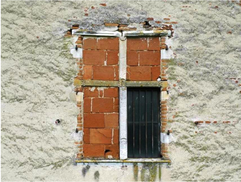
Figure 38 : La croisée FEN 2806, au premier étage de la façade ouest.
