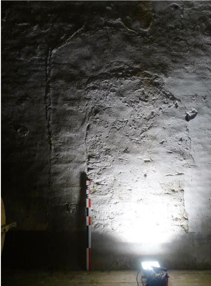
Figure 80 : Mise en évidence d'une porte sous l'enduit, au centre du mur 2603 entre les corps de bâtiment A3 et A4 (premier étage).
