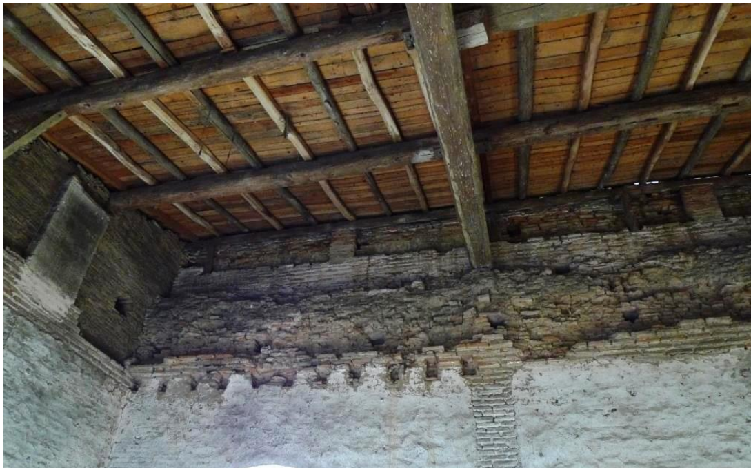
Figure 55 : Rehaussement du mur ouest de l'aile ouest (MUR 2801).
