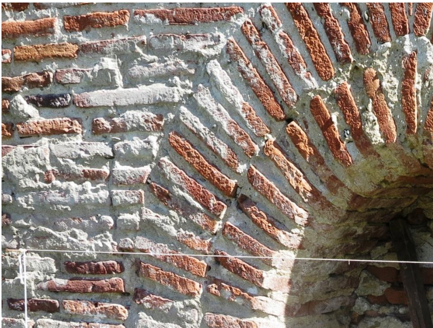
Figure 74 : Jonction entre l'arc supérieur de la porte 1805 et le parement du mur de façade nord du château.
