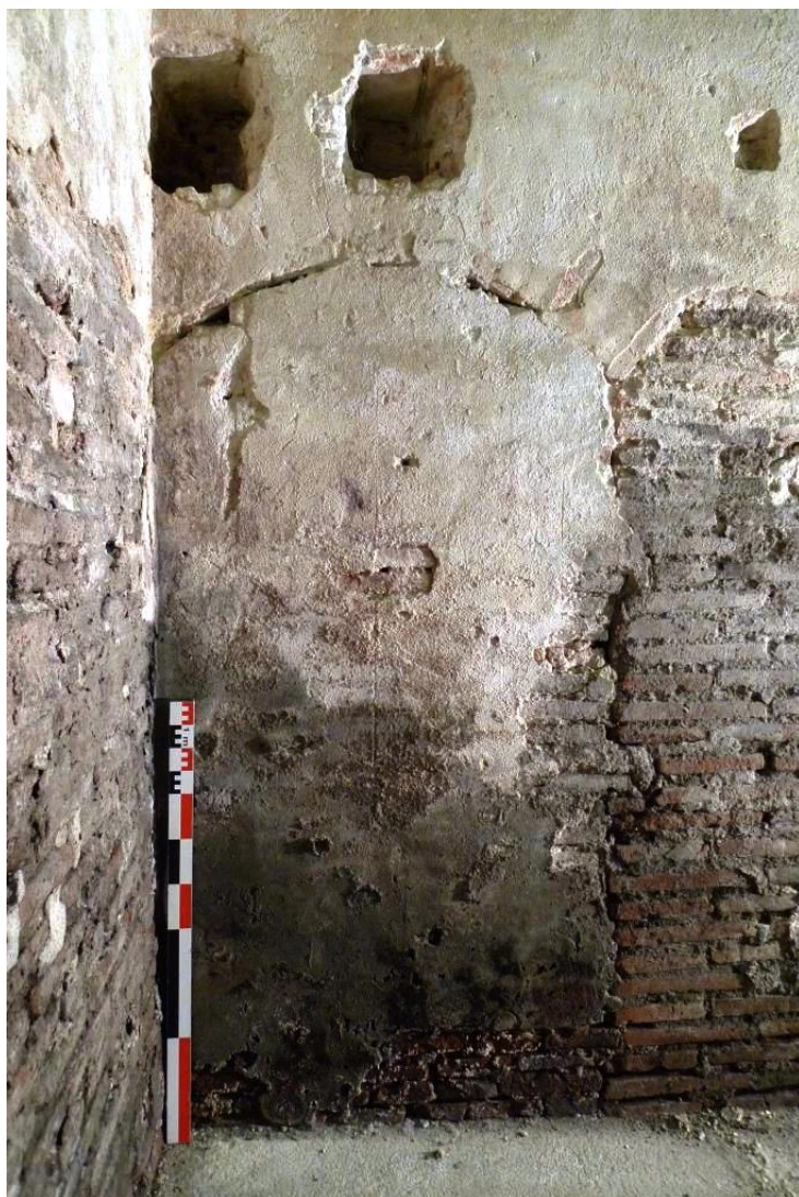
Figure 70 : Arrière-voussure de la porte 1805, au rez-de-chaussée de l'aile ouest.
