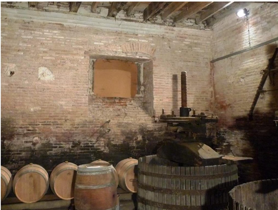
Figure 90 : Fente de jour sur le mur sud du corps de bâtiment A2 (rez-de-chaussée), élargie en jour barlong au XIX e siècle (JOU 1305).
