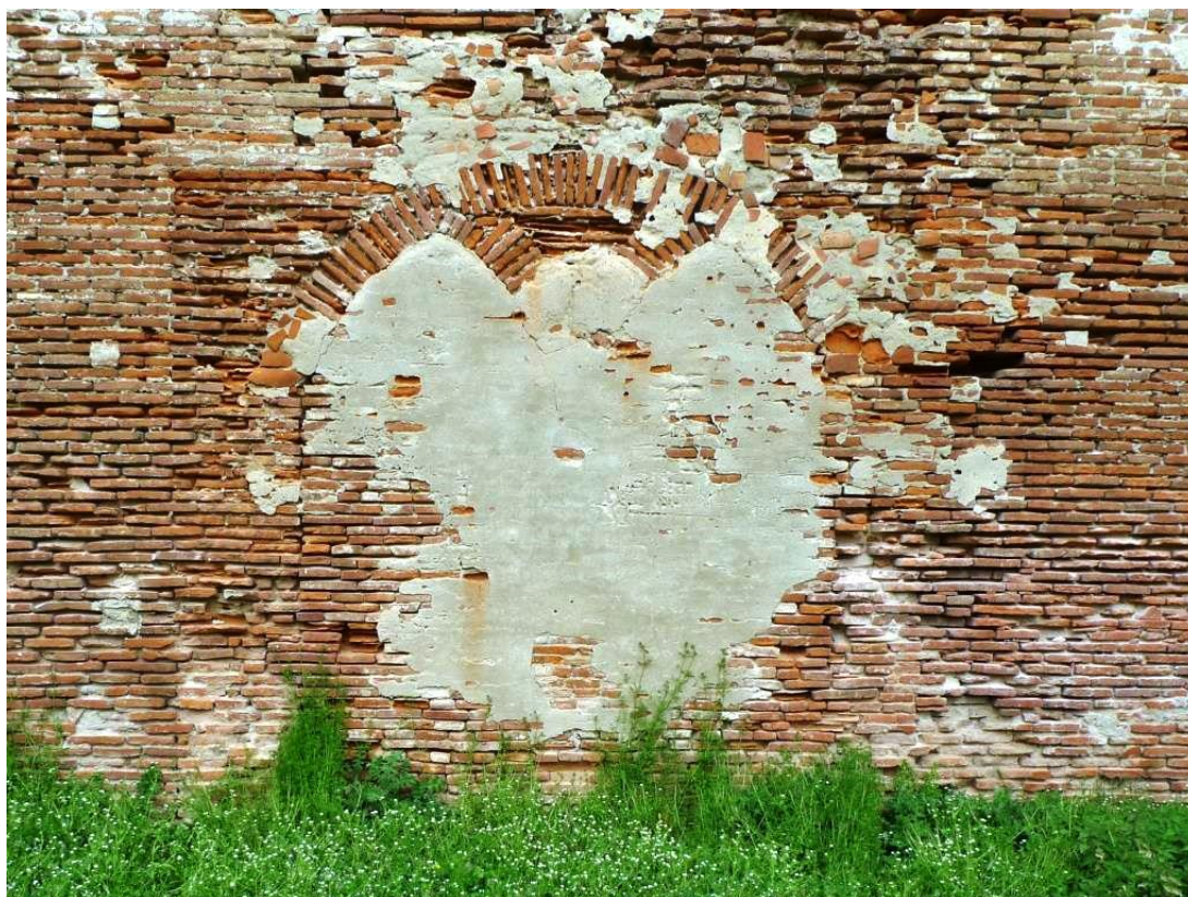
Figure 36 : La baie 1608, rez-de-chaussée de la façade ouest.
