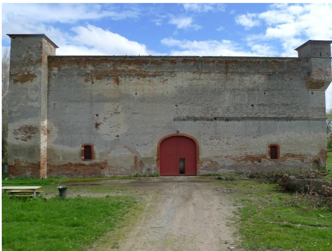
Figure 25 : Vue générale de la façade nord, actuelle façade principale.
