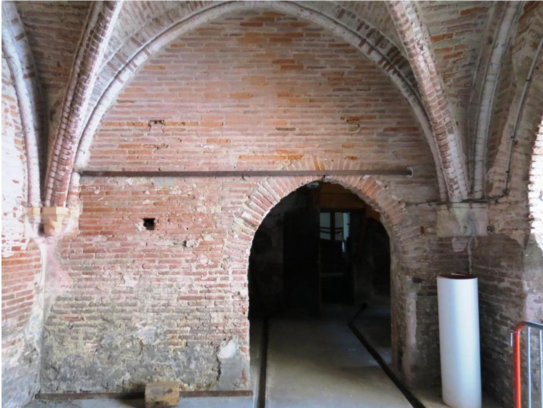
Figure 57 : Le mur ouest de la tour porche, avec la porte 1405 à droite.
