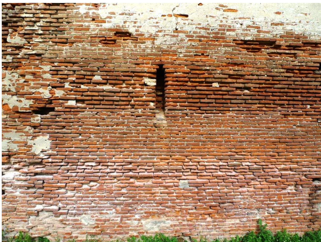
Figure 37 : Le jour 1609, rez-de-chaussée de la façade ouest.
