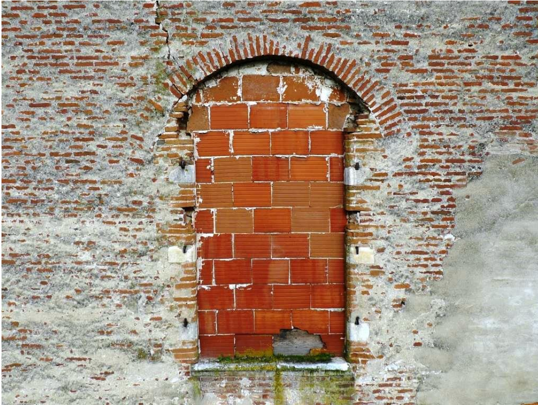
Figure 40 : La fenêtre 2705, premier étage de la façade ouest ; arc d'une fenêtre géminée transformée en croisée au XVII e siècle (traces d'arrachement des croisillons et du linteau).
