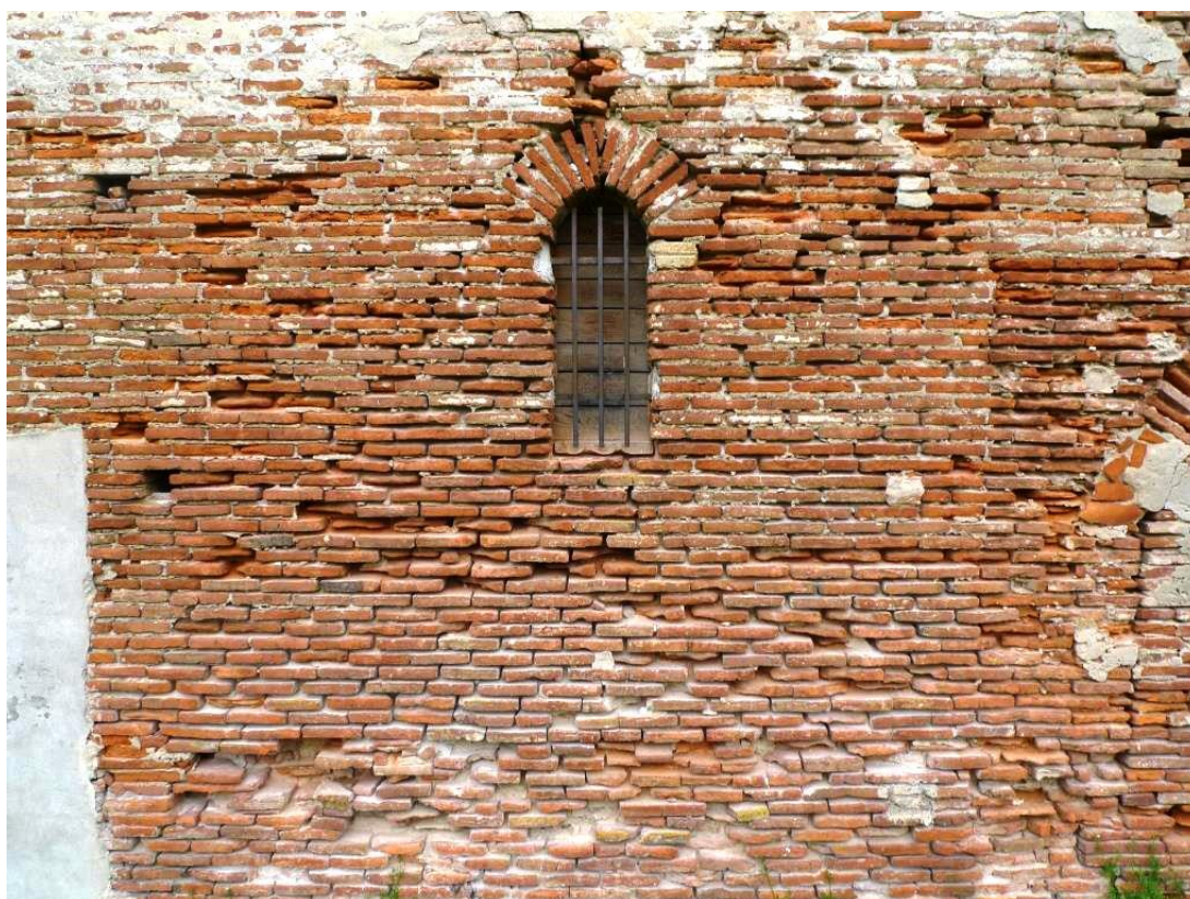
Figure 35 : Le Jour 1707, rez-de-chaussée de la façade ouest.
