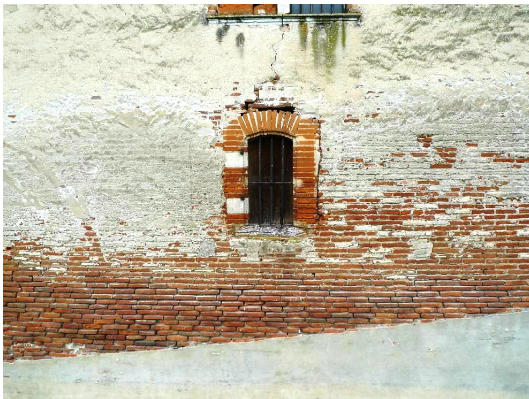
Figure 34 : Le jour 1804, rez-de-chaussée de la façade ouest.
