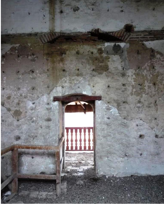
Figure 93 : Arrière-voussure de la fenêtre géminée, mur nord de la tour (A1), deuxième étage ; remplacée par la porte d'accès au pigeonnier au XVII e siècle. À gauche, l'escalier du XIX e siècle (cl. L. Gérardin).
