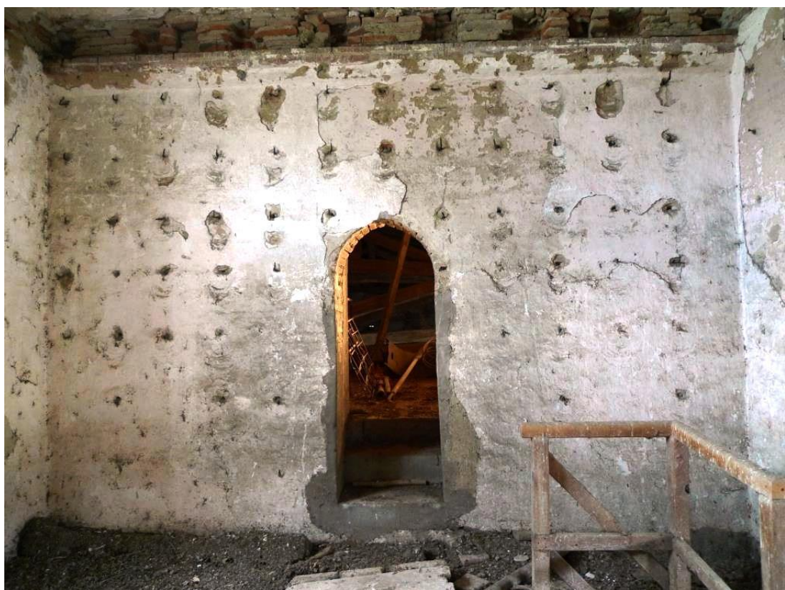
Figure 83 : Porte d'accès au dernier niveau de la tour de l'aile sud (A1), au centre du mur ouest de la tour (vue depuis l'intérieur de la tour).
