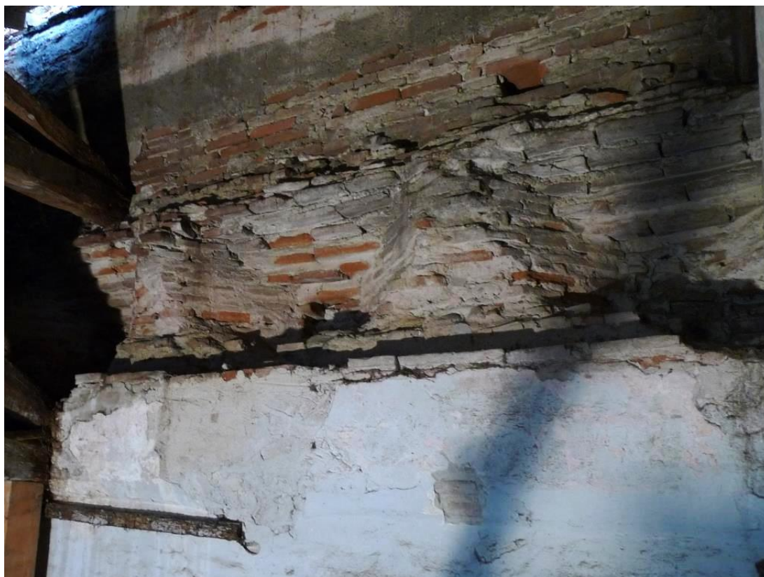
Figure 87 : Exutoires, mur gouttereau sud du corps de bâtiment A3.
