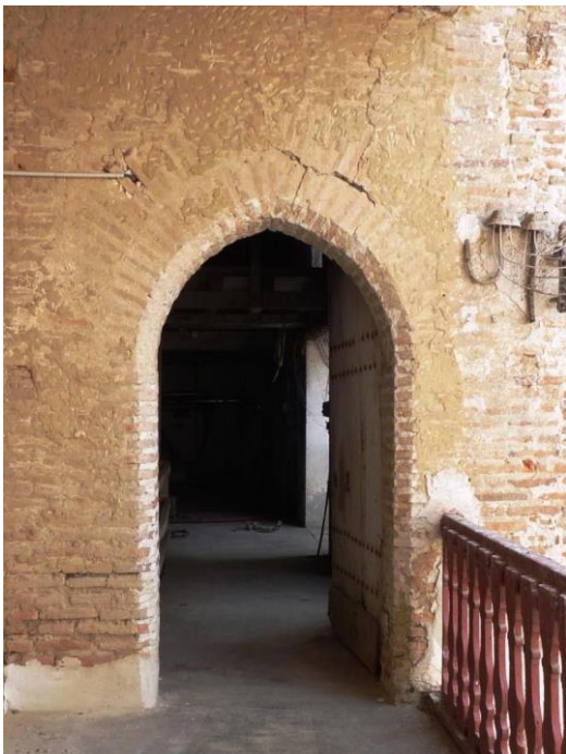
Figure 61 (à gauche) : Porte 2504 couverte d'un arc brisé à double rouleau.
