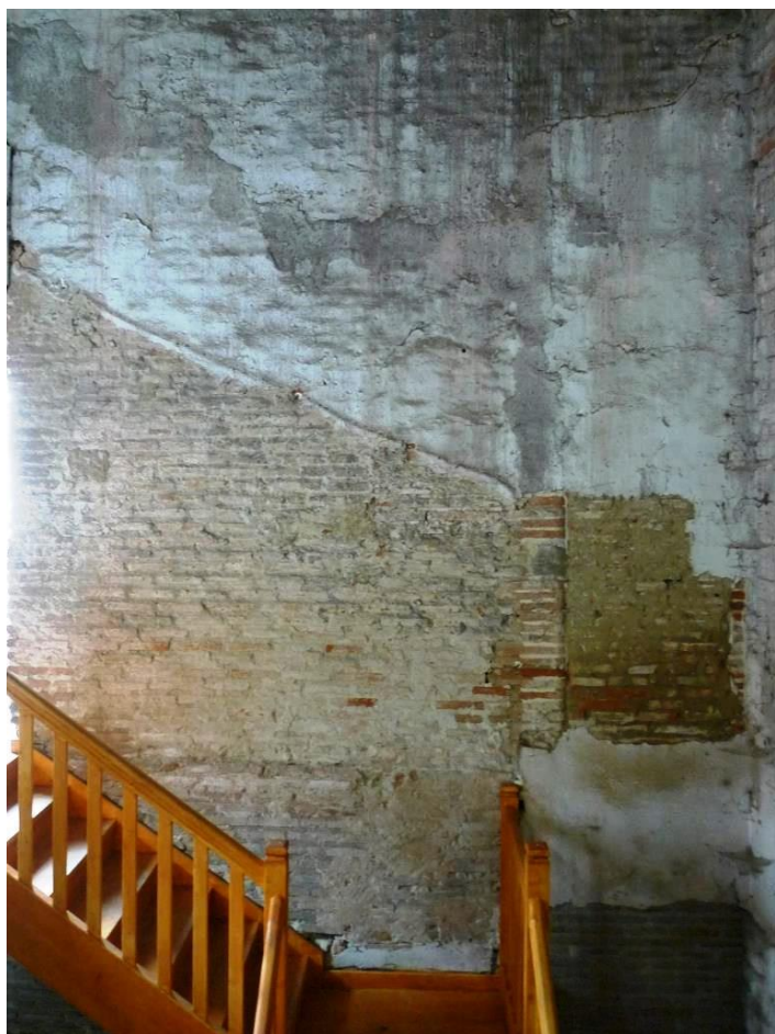
Figure 101 : Traces d'un ancien escalier et d'une porte bouchée dans le mur est du corps de bâtiment A3.
