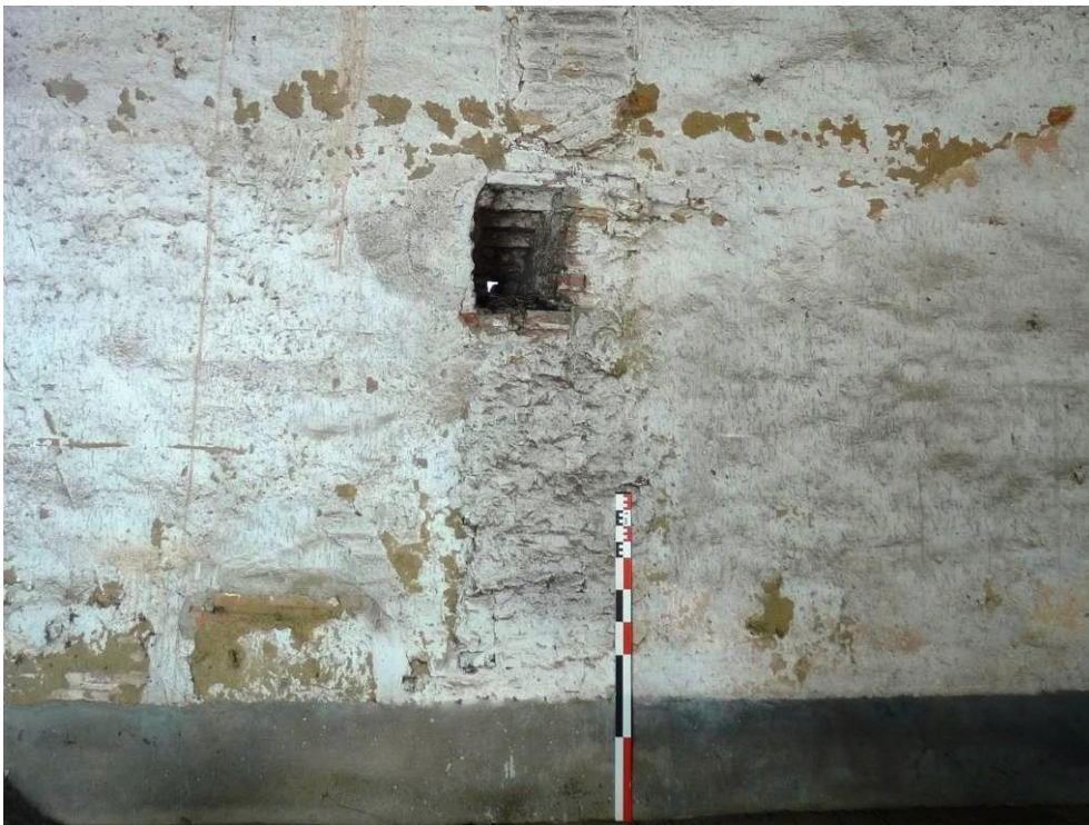
Figure 41 : Ancien système d'évacuation des eaux de pluie du bâtiment B (EVA 2809), vu de l'intérieur. Au-dessous, traces d'arrachement de l'ancien mur gouttereau nord du bâtiment ; au-dessus à droite, traces de l'ancien pignon du bâtiment, connecté à l'évacuation.
