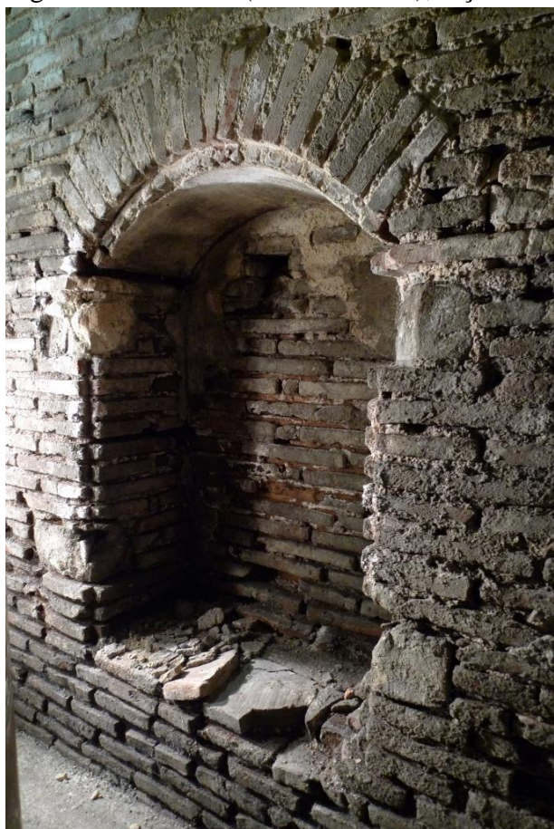
Figure 97 : Placard (1705) à double-battant sur le mur nord du corps de bâtiment A4 (rez-de-chaussée, pièce 17).
