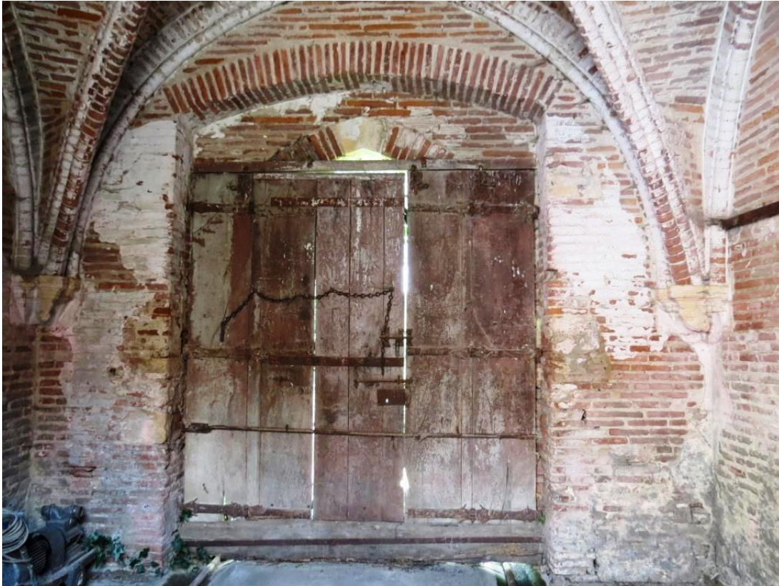
Figure 60 : Arrière-voussure du portail principal sud (POR 1404) : seul le rouleau inférieur de l'arc est visible de ce côté.
