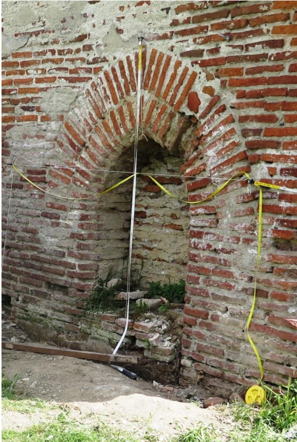
Figure 73 : Porte 1805 après dégagement de la zone et matérialisation des axes.
