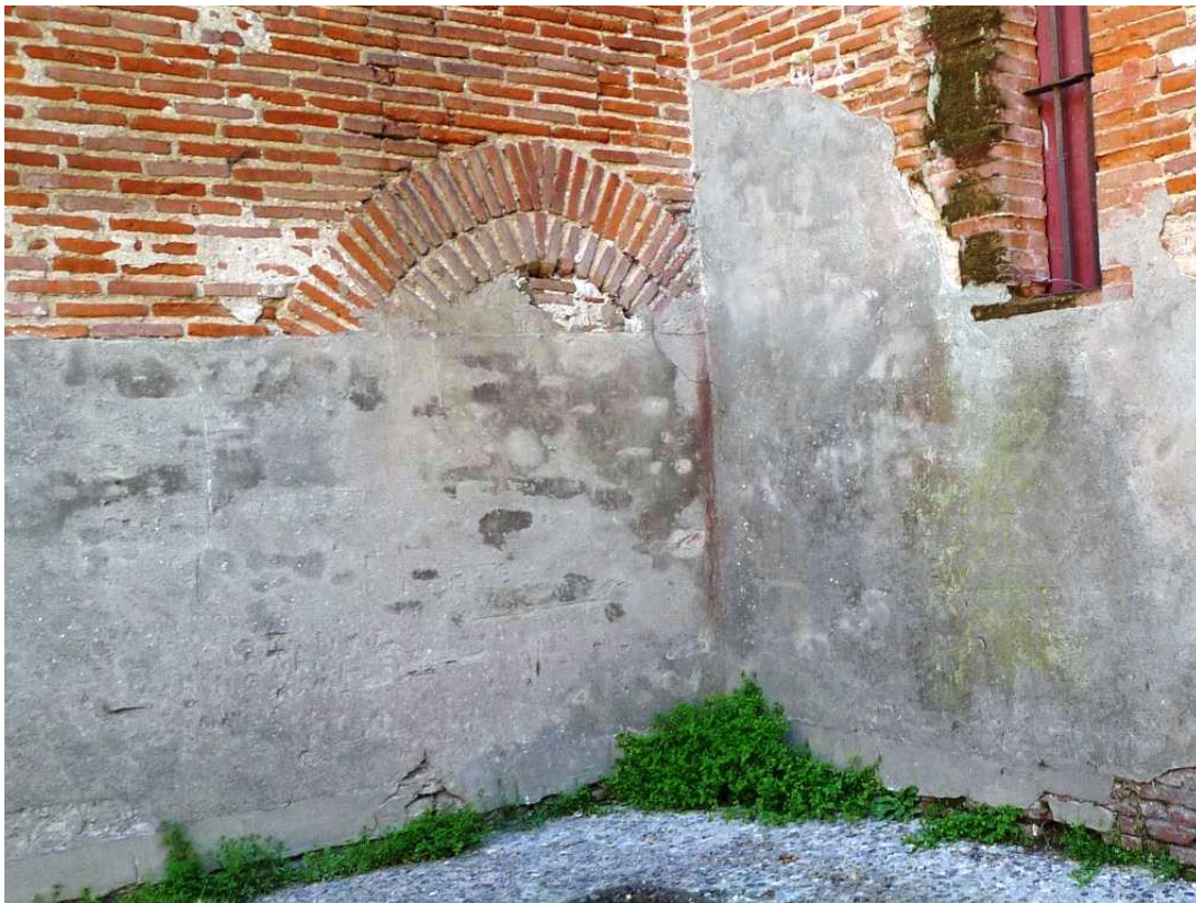
Figure 66 : Porte 1108, entre le corps de bâtiment A3 et la cour intérieure.
