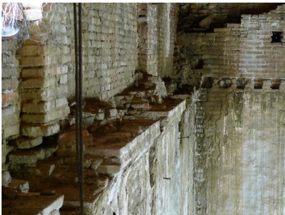
Figure 88 : Vestiges d'exutoires au-dessus de la corniche moulurée du mur gouttereau nord du corps de bâtiment A2.
