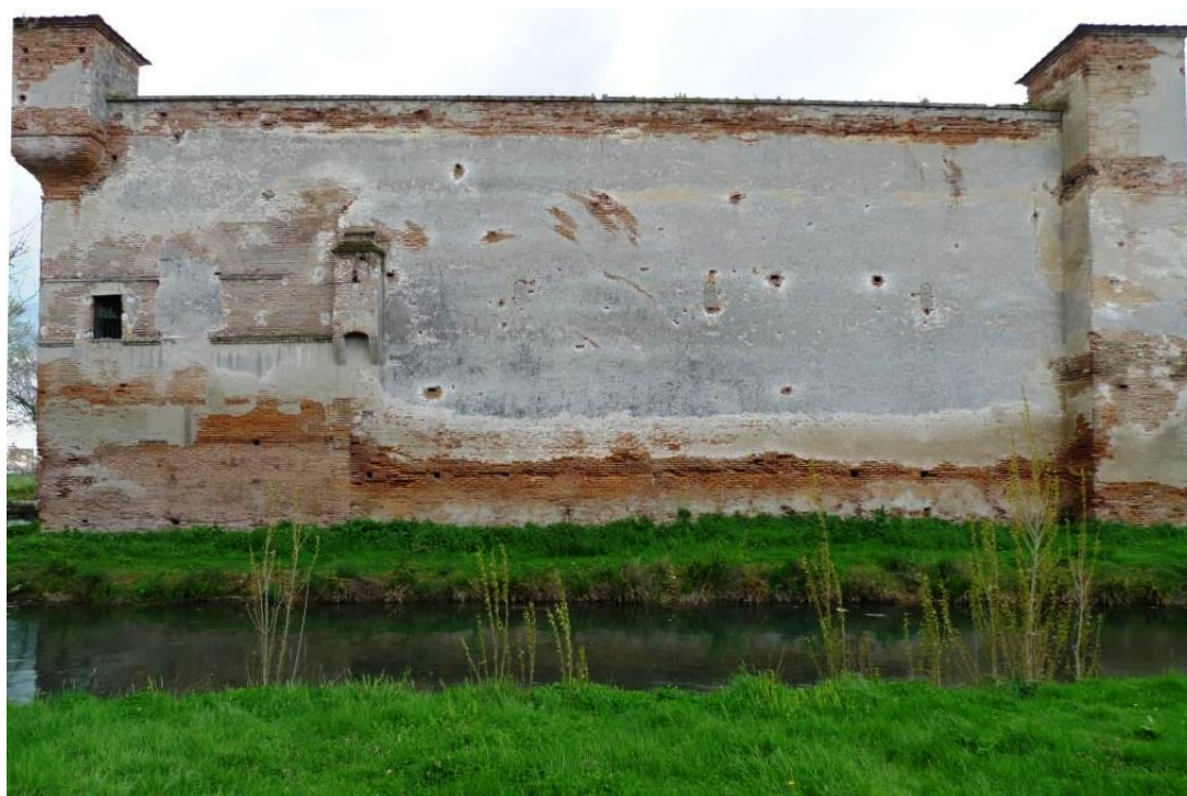
Figure 27 : Vue générale de la façade est.
