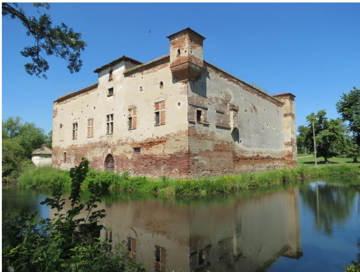
Figure 26 : Vue de l'angle sud-est du château. À gauche, l'ancienne façade principale sud.
