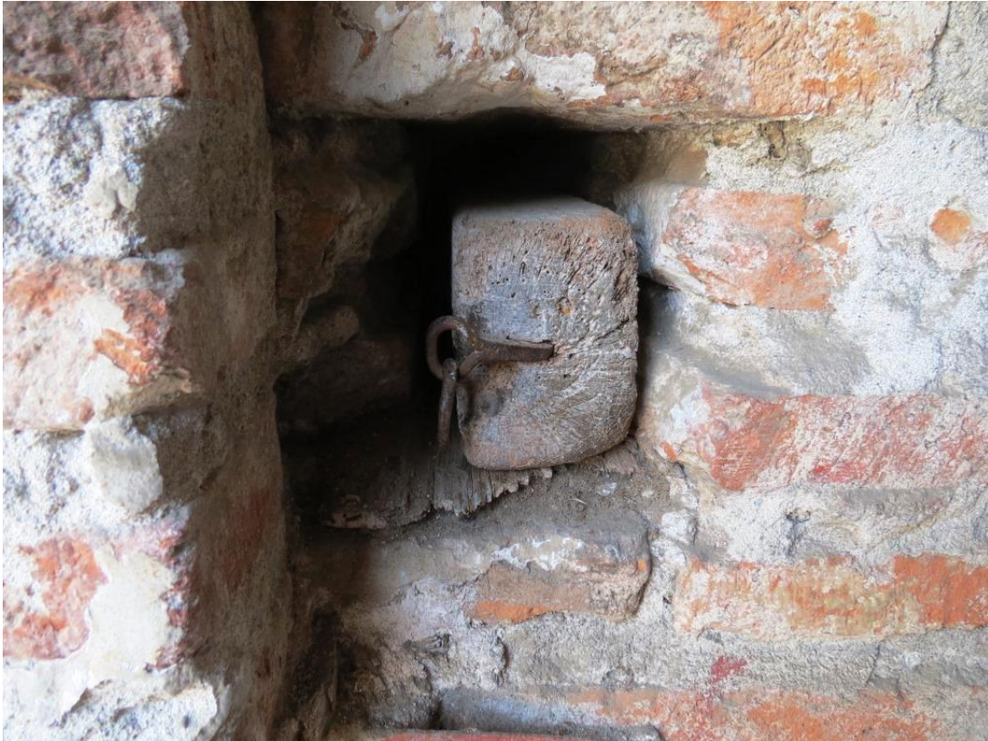
Figure 67 : Trou barillet ménagé dans le tableau sud de la porte 2504.
