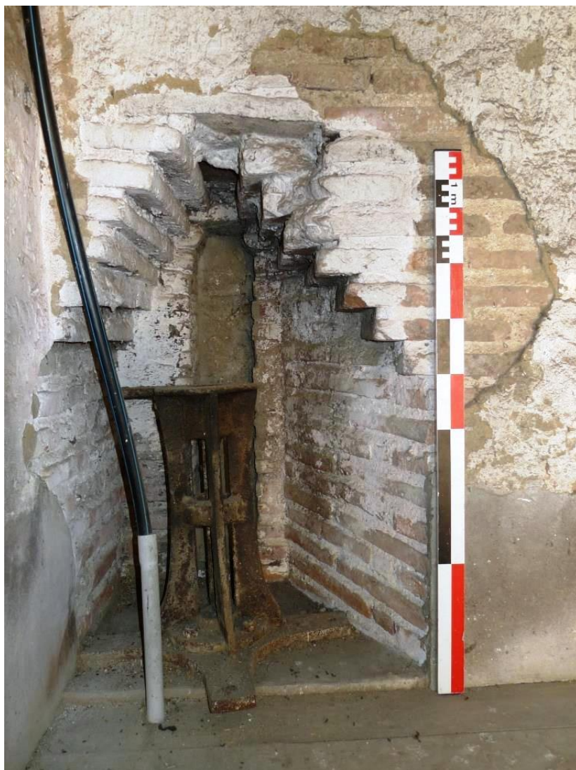
Figure 42 : Fente de jour (2804) donnant sur l'ancien espace C, partie supérieure vue de l'intérieur.
