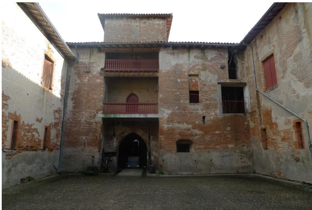
Figure 24 : Cour intérieure du château, vue depuis le nord.
