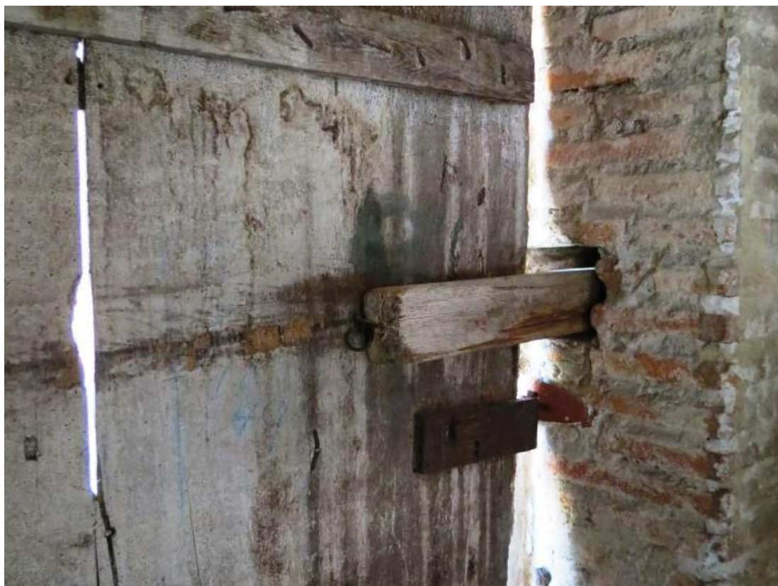
Figure 82 : Système de fermeture de la porte 2504.
