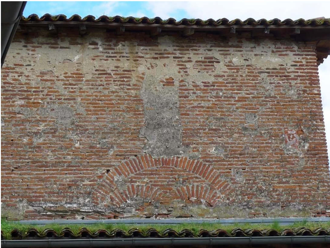
Figure 92 : Arcs d'une fenêtre géminée sur le mur nord au deuxième étage de la tour de l'aile sud (A1), surmontée d'un jour barlong couvert d'un arc en plein-cintre.
