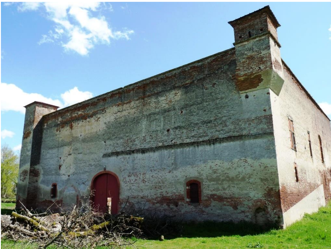
Figure 68 : Façade nord depuis le nord-ouest. La porte 1805 étudiée se trouve au rez-de-chaussée, près de l'angle ouest (à gauche).
