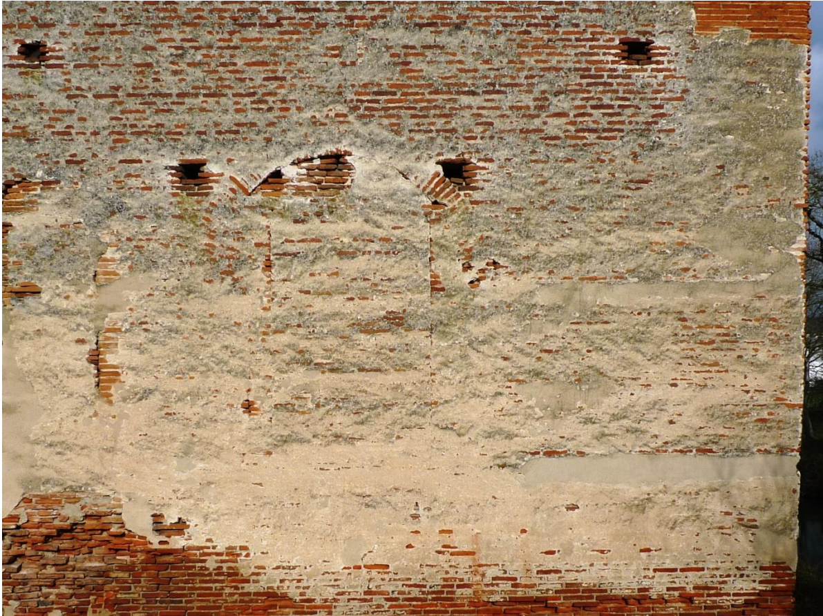
Figure 43 : Au centre, l'arc de l'ancienne fenêtre géminée (2612). À droite, deux traces d'enduit matérialisent l'emplacement des anciens cordons d'appui et d'imposte régnaux.
