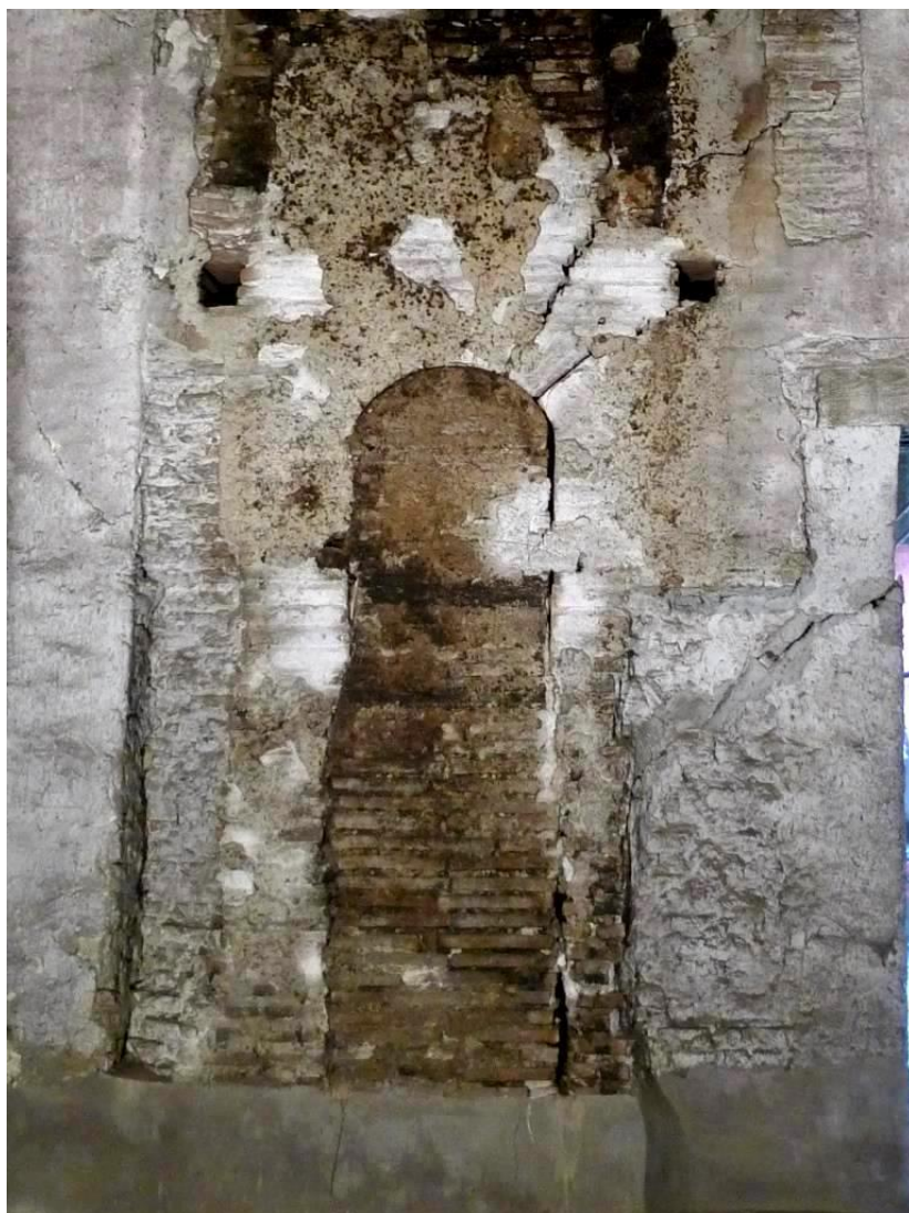
Figure 79 : Porte bouchée, transformée en cheminée (2709), au centre du mur nord du corps de bâtiment A4.
