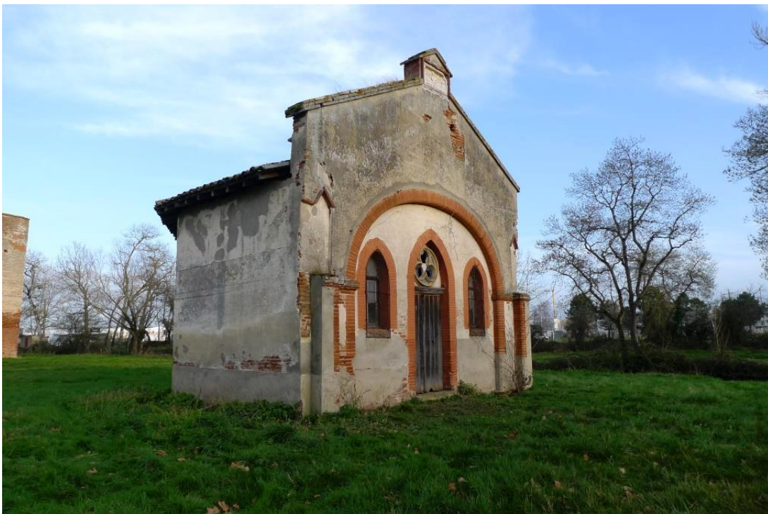
Figure 103 : La chapelle vue depuis le nord-ouest, avec sa façade occidentale néogothique.
