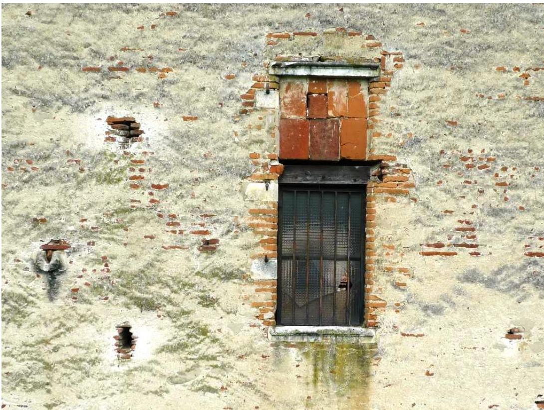
Figure 39 : La demi-croisée FEN 2805, au premier étage de la façade ouest. À gauche, la gargouille évacuant les eaux de pluie de l'ancien bâtiment B (EVA 2809). Entre les deux, la partie supérieure d'une fente de jour (2810) donnant sur l'ancien espace C.
