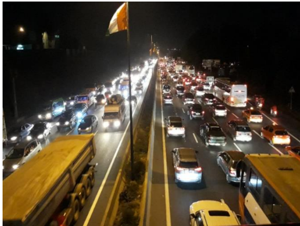
Photo 1 : Importance du trafic routier sur l'autoroute Yopougon-Adjamé
