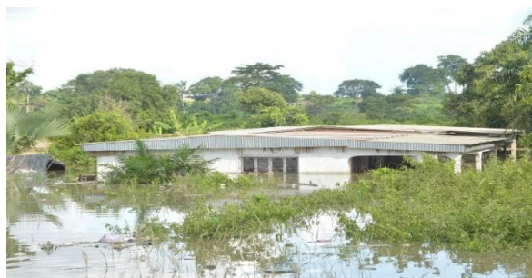
Photos 3 : Habitations inondées au quartier Solibra
