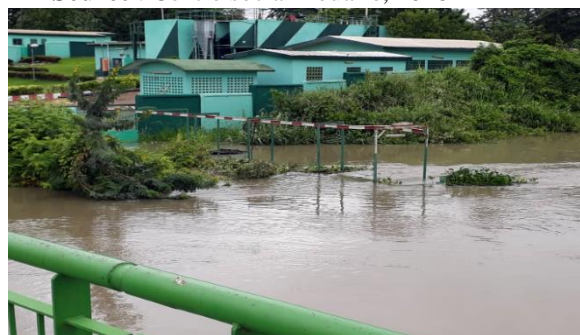
Photo 6 : Inondation de l'usine de potabilisation de l'eau au quartier Koko
