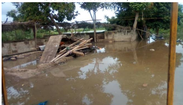
Photos 5 : Elevage de porcs et de poulets détruit au quartier Solibra
