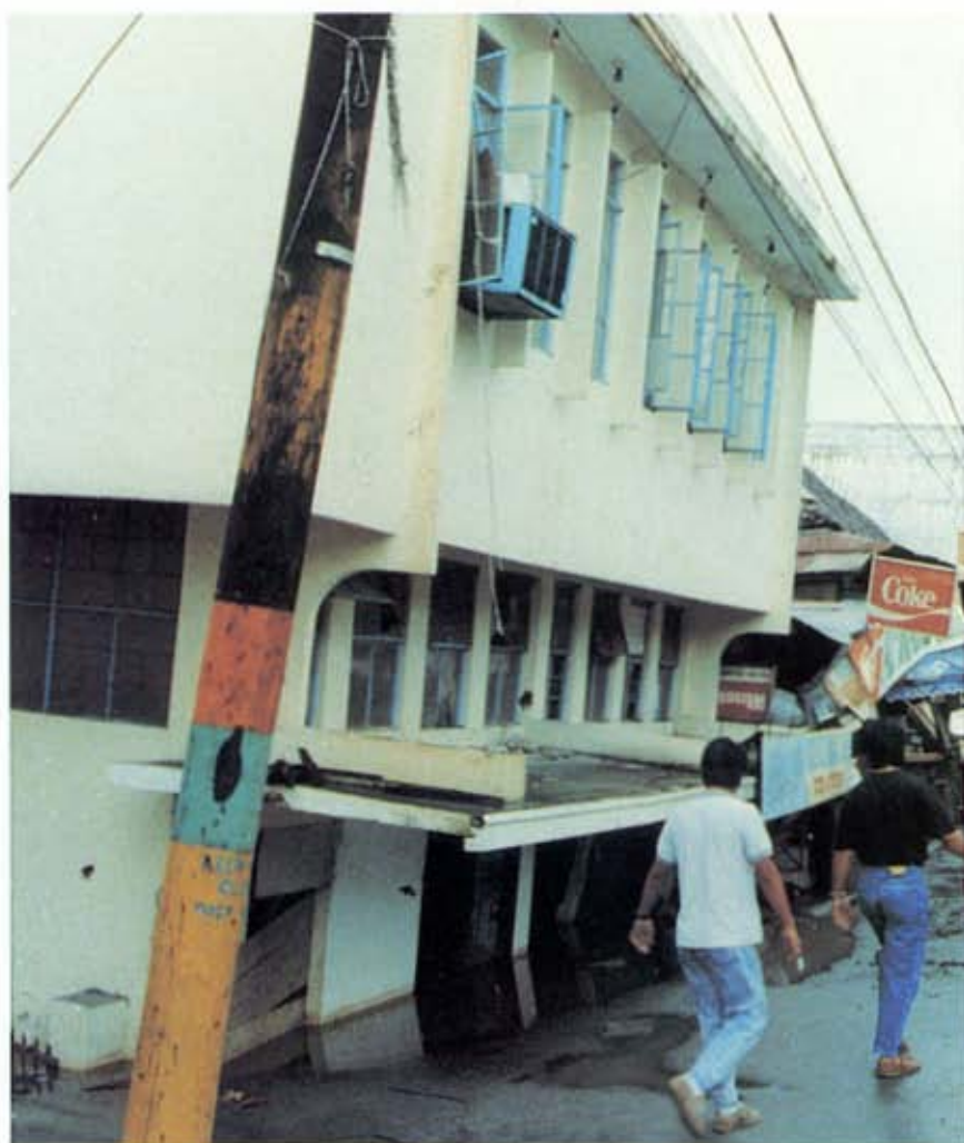
6. LIQUÉFACTION DU SOL lors du séisme de Nueva Ecija (Philippines, 1990). La liquéfaction ressemble au phénomène des sables mouvants : lorsque la pression augmente brutalement sur le sol (ici l'augmentation de pression est liée à la secousse) celui-ci perd sa cohésion et devient liquide. Le rez de chaussée de l'immeuble a presque totalement disparu dans le sol sableux qui s'est liquéfié lors de la secousse, alors que la structure d'ensemble de l'immeuble n'a pas été affectée.
