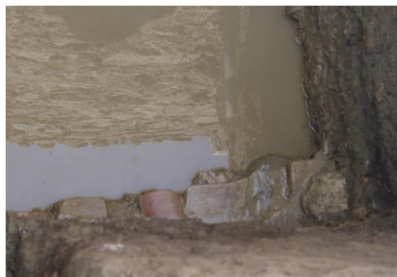
Fig. 35 : vestiges de la couche de démolition US 4659, vues vers l'ouest (RAFAD 2019)
