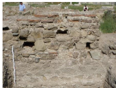
Fig. 24 : le mur MR 4003, vu vers l'ouest (RAFAD 2018)
