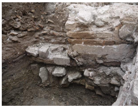
Fig. 55 : le seuil US 4576, vu vers l'ouest (RAFAD 2018)
