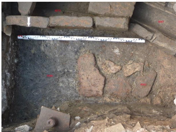
Fig. 8 : SL 4082 et, au sud, la structure 4072 et la canalisation C 4087 (RAFAD 2018)
