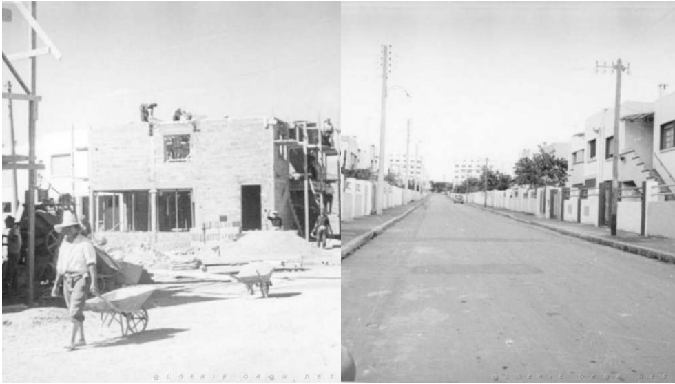
Photo 2 : Travaux de construction des pavillons Castors Jourdain – (Oran) (1956-1958)
