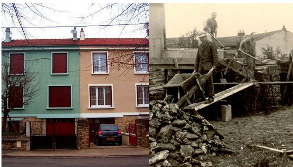
Photo 1 : Le chantier des Castors de Noisy-le-Sec (France) 1951
