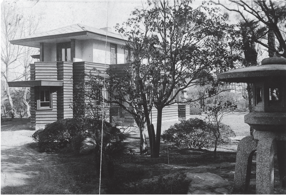
Fig. 6 : Antonin Raymond, résidence de l'Ambassadeur de France à Tôkyô, 1924. La maison réalisée pour Paul Claudel, après le Grand tremblement de terre du Kantô de 1923. Archives du Karuizawa Studio.
