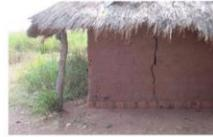
Fissures verticales à cause d'un manque de fondation résistante
