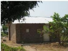
Renforcement des angles et des jambages avec piliers plus épais en adobe et du soubassement avec plus d'épaisseur. Le renforcement des angles est une bonne stratégie en zone sismique
