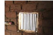
La plupart des linteaux de cette typologie sont sous dimensionnés pour supporter la charge de briques durablement
