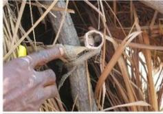
Utilisation de moustiquaires pour attacher les différents éléments de la structure des maisons en paille et en torchis. Très flexible dans zone ventée
