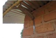
Charpentes attachées aux murs pour éviter l'arrachement dû aux forts vents
