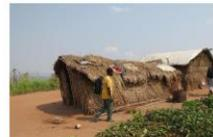
Absence de contreventement dans les murs et pourriture ou attaque des termites à la base des sticks -> manque de stabilité face aux vents
