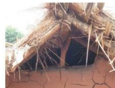
Ouverture dans le mur au niveau du foyer de la cuisine pour faciliter la sortie de la fumée
