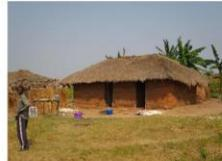
Toiture à quatre pans forme aérodynamique dans zone exposée aux vents violents
