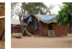
Le manque d'entretien (crépissage, remplacement des sticks détériorés...) est à l'origine de nombreux problèmes dans les murs en torchis
