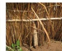
Les poteaux en bois (ainsi que la paille) pourrissent en contact avec l'humidité du terrain. De même, ces éléments sont attaqués facilement par les termites
