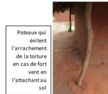
Poteaux qui évitent l'arrachement de la toiture en cas de fort vent en l'attachant au sol
