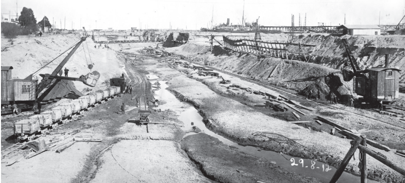
Cierre de la platea del dique de carena N° 2, 17 de diciembre de 1913. AHMPA
