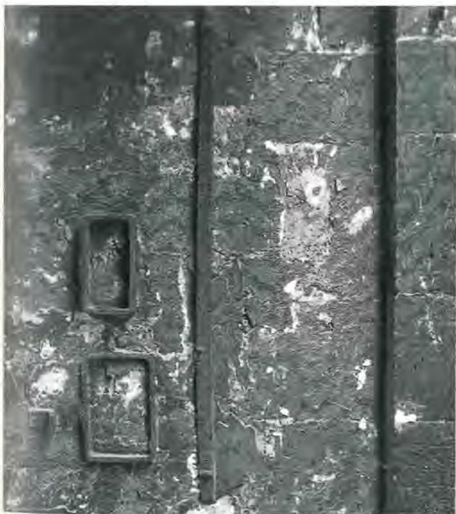
Étalon de longueur scellé dans le porche de l'ancien Hôtel de Ville de Laon.
