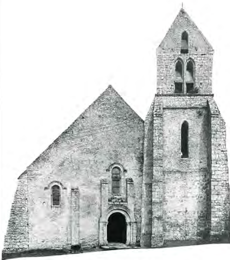
Valpuseaux (91), église Saint-Martin, photo-plan de la face antérieure réalisée à partir de deux mises à l'échelle, sur la façade proprement dite et sur la face de la tour; relevé photogrammétrique.
