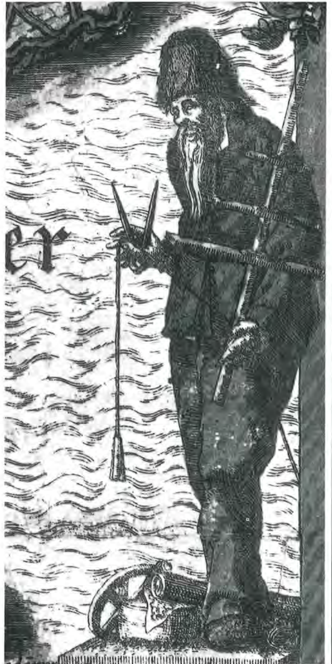
L'arpenteur et ses instruments, fil à plomb, compas, bâton de Jacob... Carte de Hollande, 1575.
