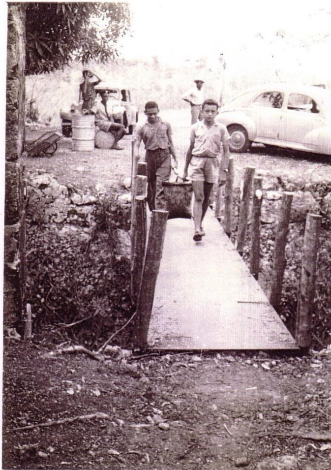
SDF. Nettoyage du Fort Fleur d'Epée. La passerelle a été construite par les scouts.
