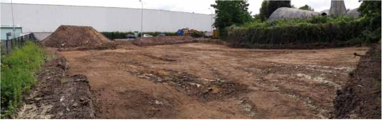
Fig. 2 Pré-décapage des remblais contemporains (18-20 juin 2019).
