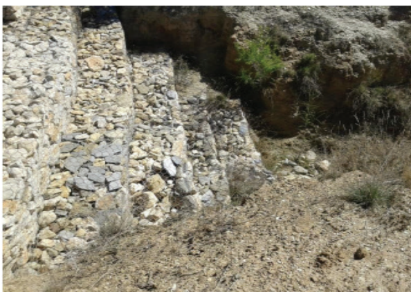
Figure 3: Seuil en gabion
