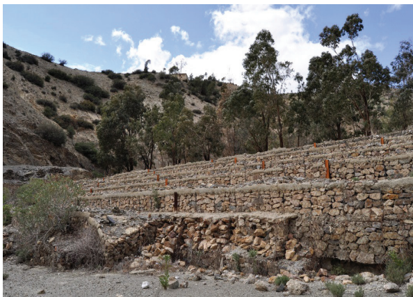
Figure 5: Barrage de sédimentation reboisé
