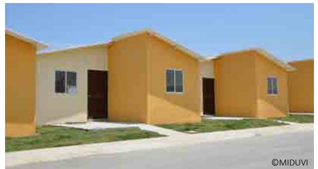
Viviendas del MIDUVI en Manta, con un factor de forma negativo de cara a la resistencia frente a los terremotos.
