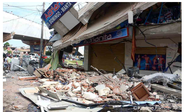
Inmueble colapsado tras terremoto en Manta.
