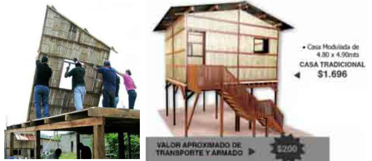
© Félix Jové Ejemplo de prototipo de vivienda modular palafítica de bajo costo.
