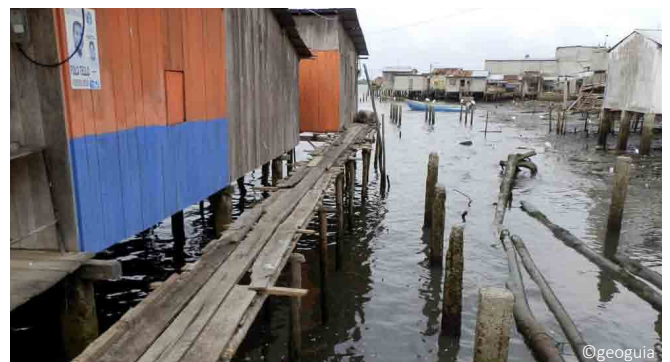
Vista de viviendas en estuario, pilotes de madera y de hormigón.
