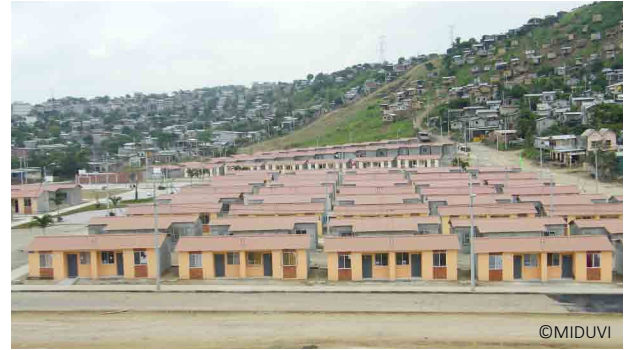
Viviendas construidas en terrenos viabilizados vs. viviendas irregulares en las lomas con riesgo en caso de corrimientos.
