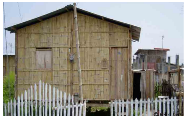
Vivienda nueva construida en base a un modelo vernáculo con cambio de los materiales de cubierta.
