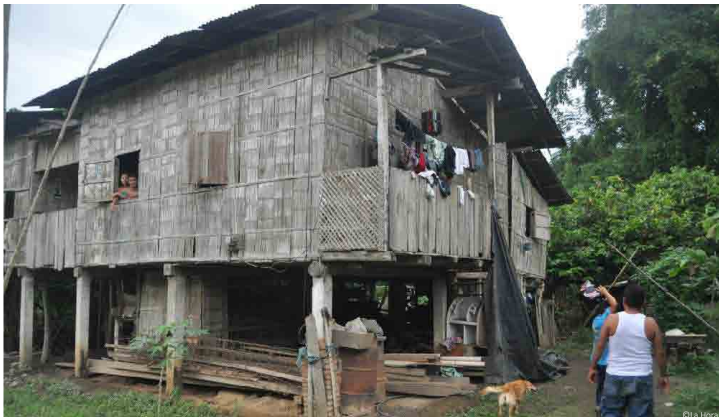
Vivienda vernácula en Los Ríos, con materiales tradicionales y hormigón en los pilotes en contacto con el suelo.
