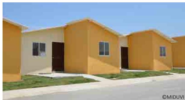
Viviendas del MIDUVI en Manta, con un factor de forma negativo de cara a la resistencia frente a los terremotos.
