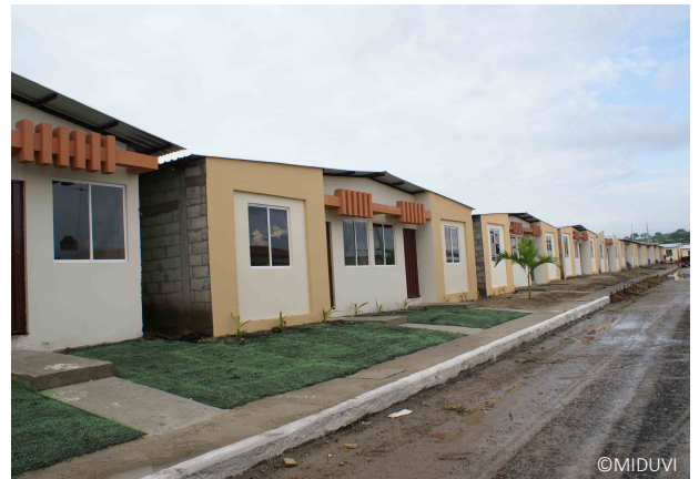
Viviendas del MIDUVI en Manta, sin consideración de los factores climáticos y culturales.
