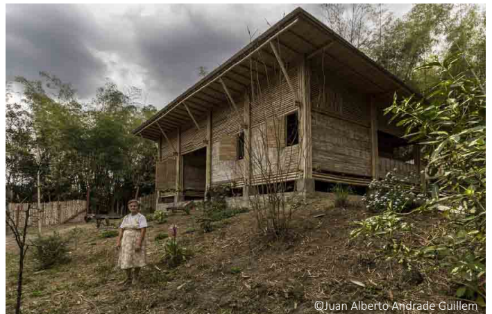
Vivienda contemporánea con materiales locales y mejoras constructivas en la parroquia Convento de Manabí.
