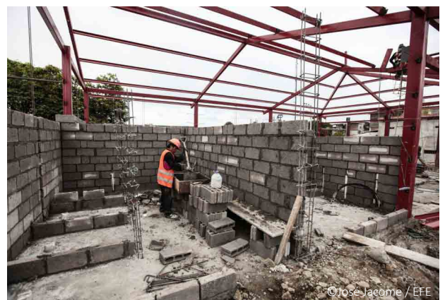
Reconstrucción de mercado en Pedernales tras terremoto.
