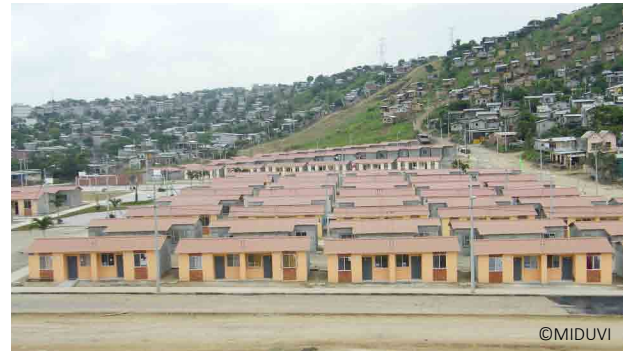
Viviendas construidas en terrenos viabilizados vs. viviendas irregulares en las lomas con riesgo en caso de corrimientos.
