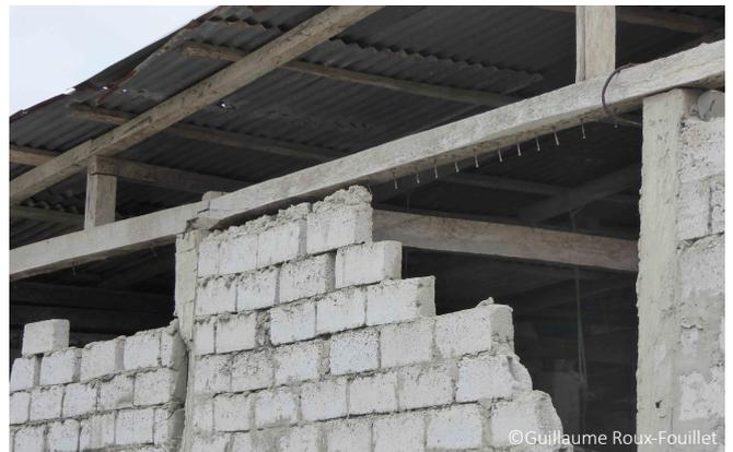
Es difícil anclar los muros de albañilería a la estructura de madera.
