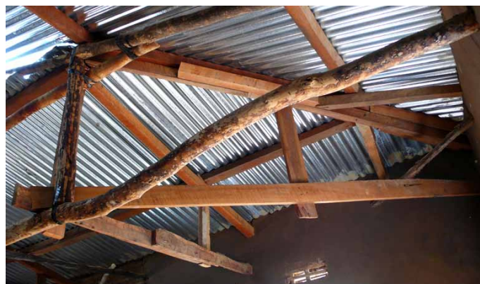
Vue intérieure de la charpente en bois et la couverture en tôle. © CRAterre
