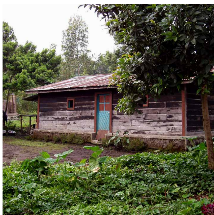
Maison avec soubassement en pierre, ossature bois, remplissage en pierres, finition en bardage bois, et couverture en tôle. Nord-Kivu. © O. Moles - CRAterre
