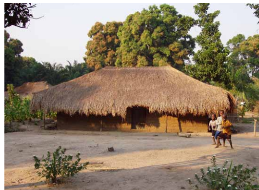
Maison avec des murs d'adobe avec structure de la toiture en bois indépendante. Toiture végétale à quatre pans. Près de Kabalo, Tanganyika. © CRAterre
