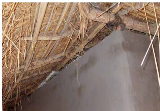
La charpente est posée sur des poteaux qui ressortent de la masse du mur, permettant ainsi un meilleur contrôle des termites. Kabalo, Tanganyika. © CRAterre
