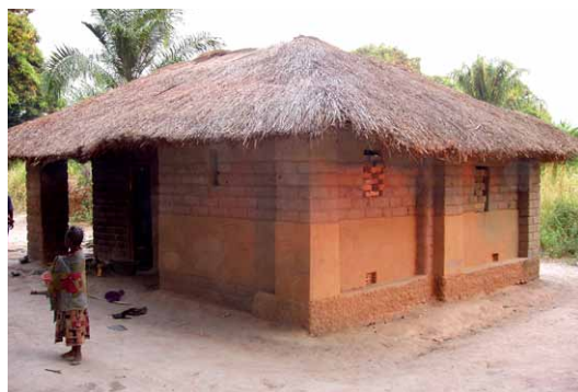
Cette maison à Kabalo (Tanganyika) a un bon système de drainage superficiel dans son périmètre. © CRAterre
