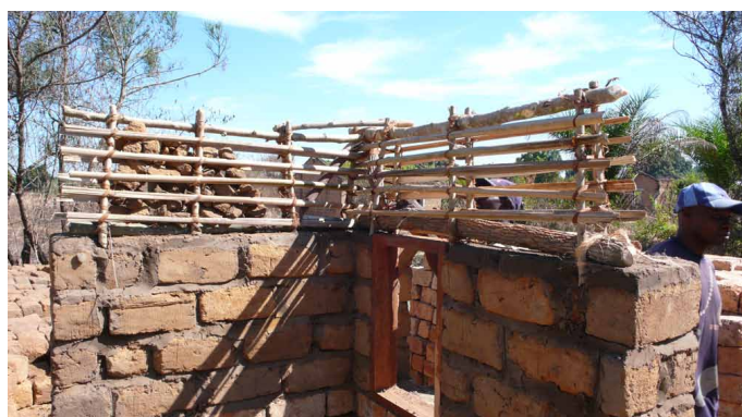
Chaînage en torchis sur les murs de maçonnerie en adobes. © CRAterre
