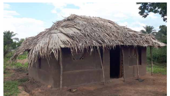
Maison en adobe avec contreforts dans les murs. Structure porteuse de la charpente en bois, séparée des murs d'adobe. Mbulungu, Kasai-Central. © NRC
