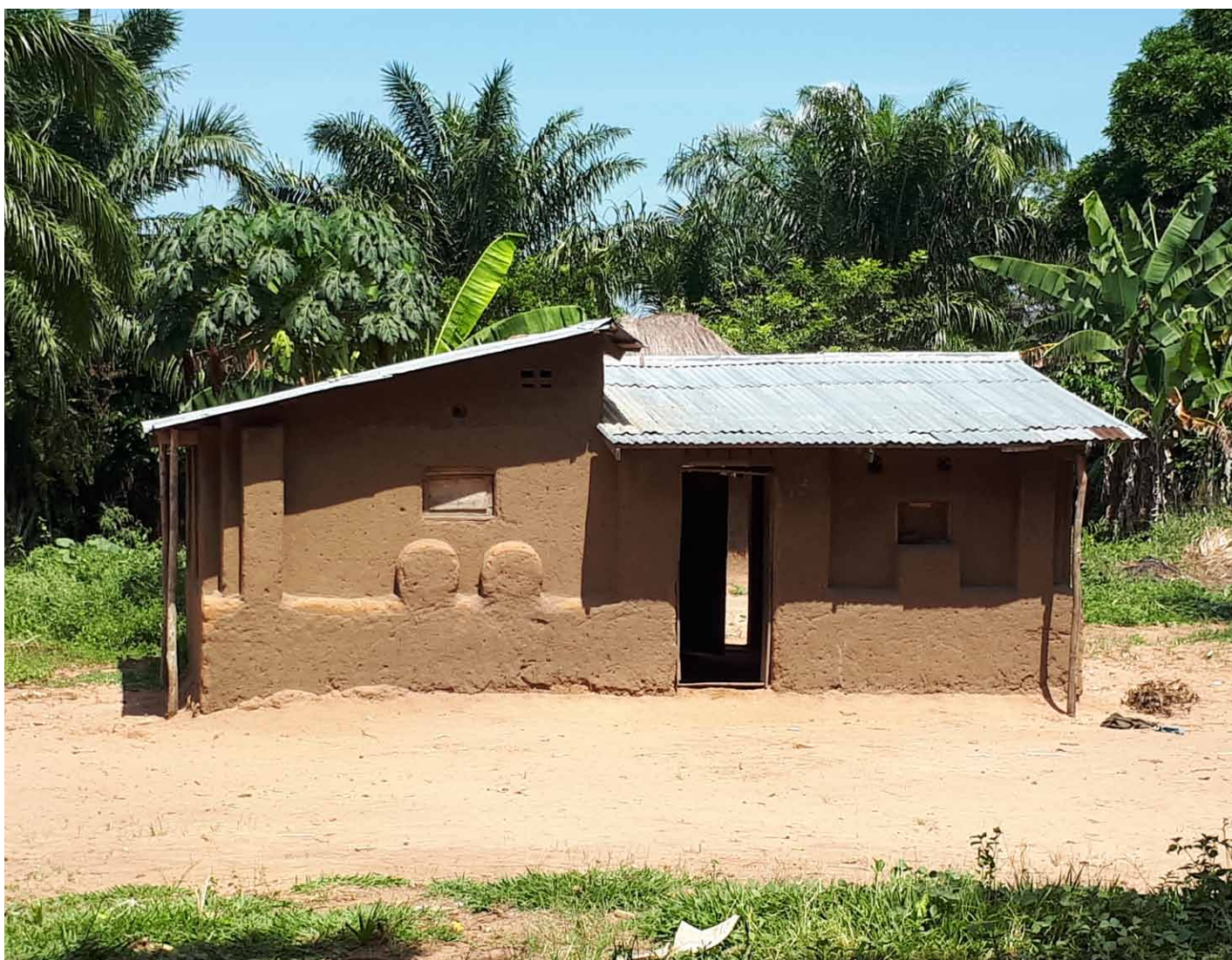
Maison en adobe avec des contreforts et soubassement aussi en adobe. Finition avec enduit de terre. La toiture est ancrée au sol par des éléments en bois en prévention d'un possible arrachement du toit en tôle lors de tempêtes de vent. Mbunlungu, Kasai-Central. © NRC
