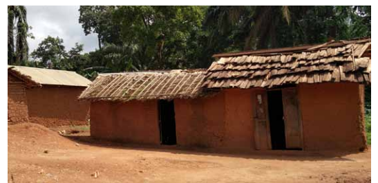
Maisons à plan quadrangulaire (C3) avec des murs en torchis (M3). Toitures à deux pans (T2) : à gauche en tôle (Cv3), au centre végétale (Cv1), à droite en bardage bois (Cv2). Bwana-Sura, Ituri. © Rafique Islam
