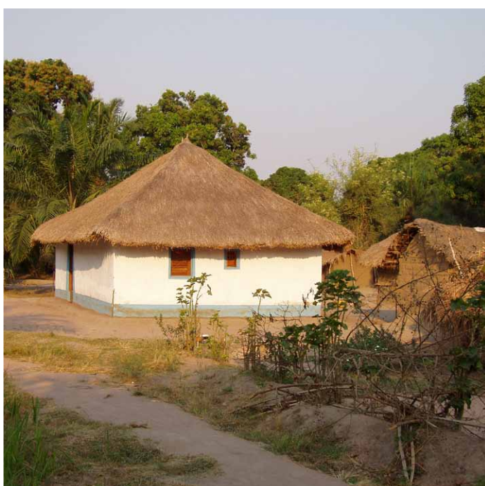
Maison en adobe avec finition à la chaux. Toiture en à quatre pans. Kabalo, Tanganyika. © O. Moles - CRAterre
