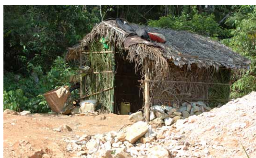
Abri construit avec une ossature bois et des fibres végétales pour les murs et la toiture (M1) dans une mine à Kailo, Maniema. CC- Julien Harneis
