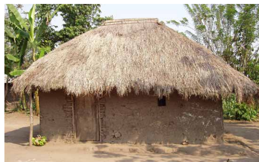
Maison à plan quadrangulaire en torchis avec couverture végétale à quatre pans. Rutshuru, Nord-Kivu. © O. Moles- CRAterre
