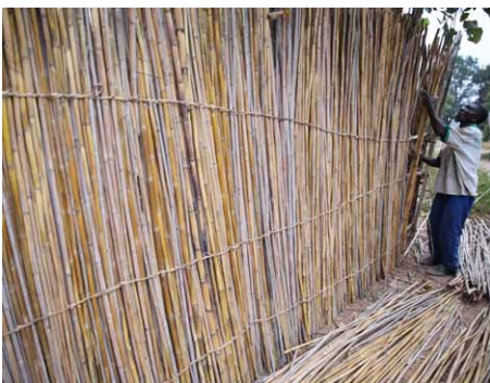
Installation de clôture en bambou à Nyunzu, Tanganyika. CC- MONUSCO- Abel Kavanagh
