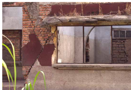
Exemple de construction ayant subi un séisme à Kabalo, Tanganyika. La structure des murs est gravement affectée, le bâtiment n'est plus sûr, un autre effort (séisme, inondation, cyclone) pourrait causer des dégâts définitifs. © CRAterre
