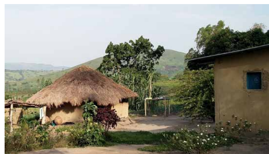
Construction à plan circulaire et toiture conique en chaume à côté d'une construction à plan quadrangulaire et toiture à deux versants en tôle. Les murs des deux constructions sont en torchis. Mandro, Ituri. © Rafique Islam
