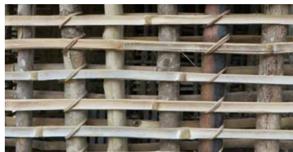
Structure en bois non équarri et bambou, tressage des lattes (horizontales) de bambou avec des lianes. © C. Belinga Nko'o- CRAterre
