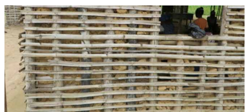
Mur en torchis rempli de terre avant enduisage extérieur et intérieur. Province du Tshopo. © C. Belinga Nko'o- CRATERre
