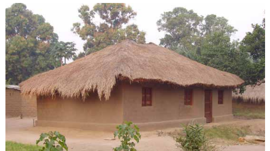
Maison à plan quadrangulaire (C3) avec des murs en adobe (M4) et toiture végétale en paille (Cv1) à 4 pans près de Kabalo, Tanganyika. © O. Moles- CRAterre
