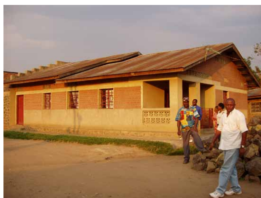
Construction avec des matériaux industriels à Rutshuru, Nord-Kivu. © O. Moles- CRAterre
