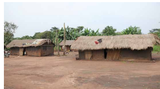
Maisons en torchis avec des barzas (vérandas) fermées par des clôtures en bambou. Toitures à deux pans en fibres. Ce type de maison s'appelle mugongo wa tembo (dos d'éléphant) en swahili. Kabeya, Maniema. © Stefan Roman
