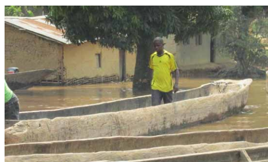
Inondations dans le centre du pays. L'absence de soubassement est à l'origine de nombreux dégâts, notamment dans les bâtiments en terre. CC- Terese Hart
