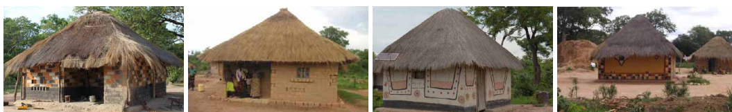
Maisons en adobe avec toiture à quatre pans et diverses décorations murales dans le territoire de Sakania, Haut-Katanga. © Aude Peleket - CRAterre
