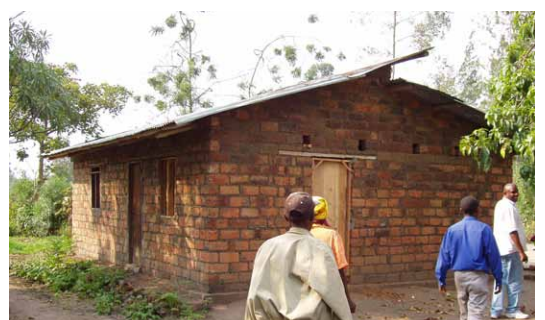
Maison à plan quadrangulaire (C3) avec des murs en briques cuites (M5) et toiture en tôle (Cv3). Mandro, Ituri. © O. Moles- CRAterre
