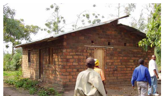
Maison à plan quadrangulaire (C3) avec des murs en briques cuites (M5) et toiture en tôle (Cv3). Mandro, Ituri. © O. Moles- CRAterre
