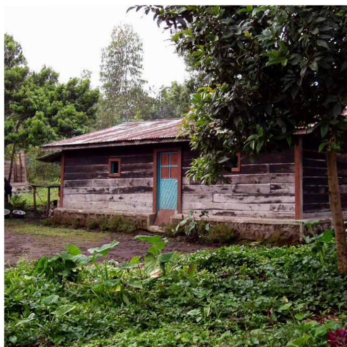
Maison avec soubassement en pierre, ossature bois, remplissage en pierres, finition en bardage bois, et couverture en tôle. Nord-Kivu. © O. Moles - CRAterre
