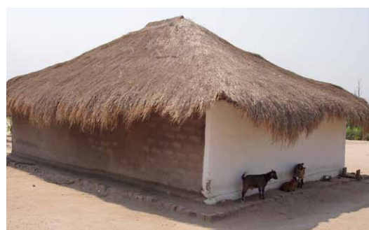
Façade exposée protégée avec un enduit et une peinture à la chaux. © O. Moles- CRAterre
