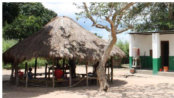
Espace couvert à plein air avec toiture en chaume, laquelle aide à maintenir une ambiance fraîche. Près de Dubie. Haut-Katanga. CC-Tom Skrinar
