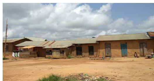
Village de Ndalya, Ituri. Maisons en torchis en disposition linéaire avec des toitures en tôle à deux versants. © Rafique Islam
