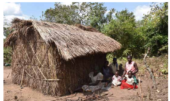
Abris de réfugiés du Sud Soudan construits avec toiture et murs en fibres végétales à Kendrio, Territoire d'Aru, Ituri. CC- MONUSCO- Anne Herrmann
