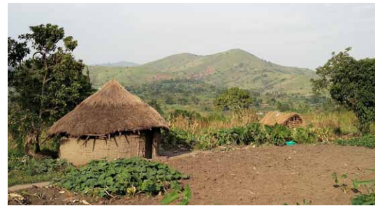
Maison à plan circulaire (C2) en torchis (M3) avec couverture végétale (Cv1) conique. Mandro, Ituri. © Rafique Islam
