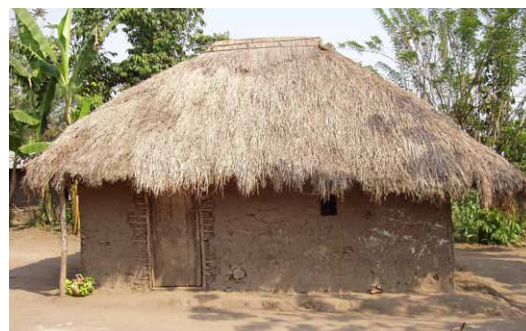
Maison à plan quadrangulaire en torchis avec couverture végétale à quatre pans. Rutshuru, Nord-Kivu. © O. Moles- CRAterre
