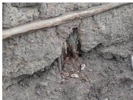
Le contact du bois avec l'humidité du terrain crée des problèmes de pourriture du bois. Maison près de Goma, Nord-Kivu. © G. Paccoud- CRAterre
