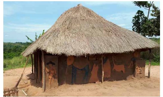
Maison en adobe avec contreforts et décorations murales. Toiture en chaume avec structure indépendante en bois. Kasai-Central. © NRC
