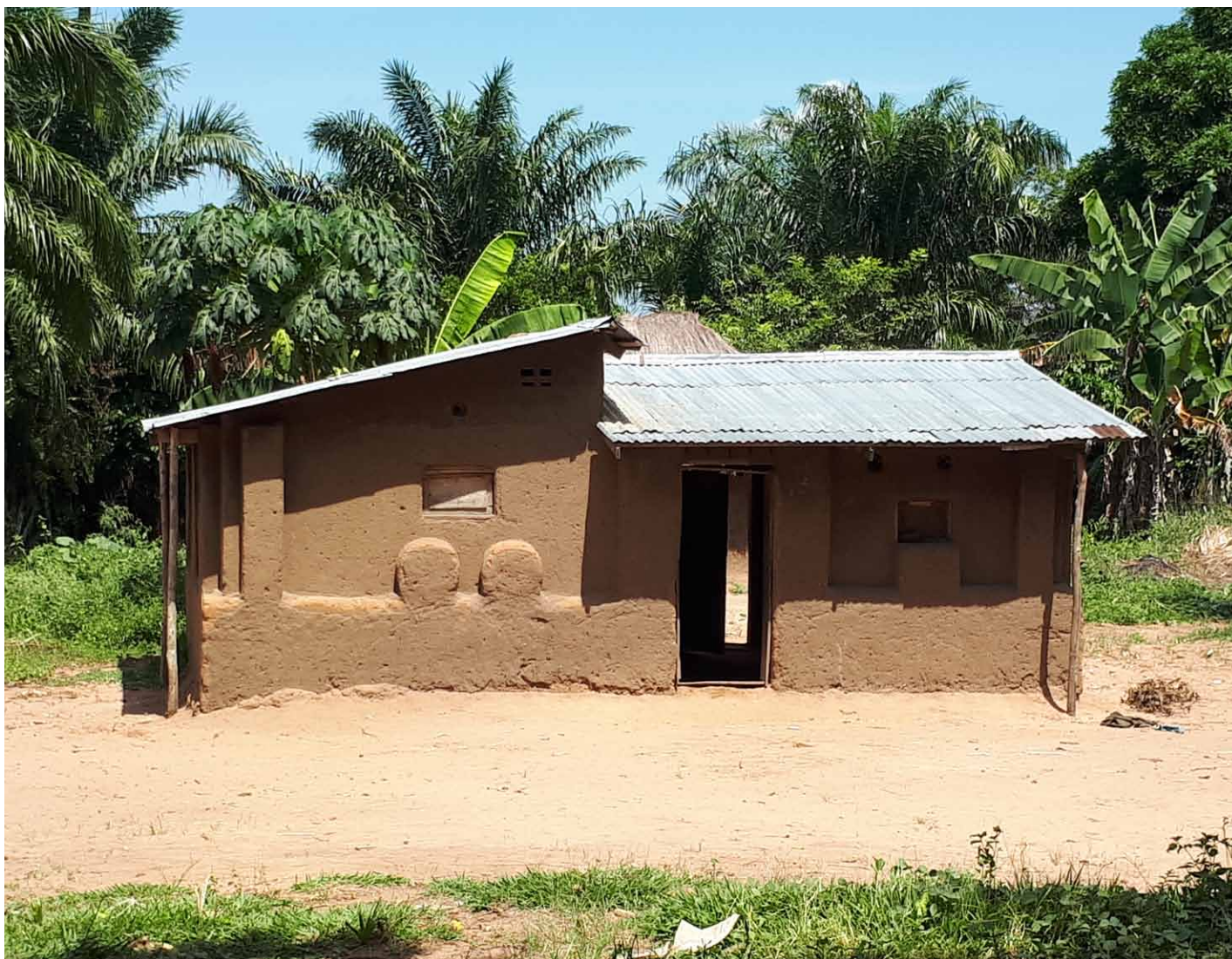
Maison en adobe avec des contreforts et soubassement aussi en adobe. Finition avec enduit de terre. La toiture est ancrée au sol par des éléments en bois en prévention d'un possible arrachement du toit en tôle lors de tempêtes de vent. Mbulungu, Kasai-Central. © NRC
