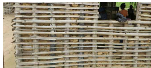
Mur en torchis rempli de terre avant enduisage extérieur et intérieur. Province du Tshopo. © C. Belinga Nko'o- CRAterre
