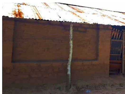
Cette toiture est attachée au sol par des poteaux en bois qui empêchent son arrachement par le vent. © NRC
