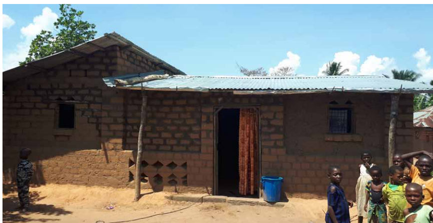
Maison en adobe avec contreforts et soubassement en adobe avec décorations. Toiture en tôle avec véranda. Kasai-Central. © NRC
