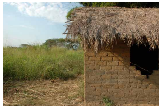
Maison quadrangulaire en adobe avec toiture en chaume près de Fizi, Sud-Kivu. CC- Julien Harnes
