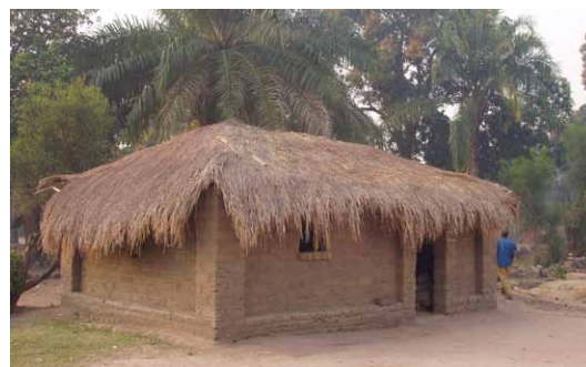
La forme compacte de la maison, ainsi que la forme des murs avec des colonnes dans les angles et dans les jambages assurent une bonne résistance en cas de séisme, et une certaine durée face à l’érosion de l’eau grâce au soubassement plus large en terre (masse d’usure). En cas d’inondation exceptionnelle les murs sont détruits. Près de Kabalo, Tanganyika. © CRAterre
