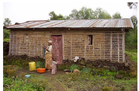
Maison en zone volcanique avec un soubassement en pierre, une structure porteuse verticale en bois avec un clayonnage en lattes horizontales de bambou à l'extérieur et à l'intérieur fendu et rempli de pierres.
