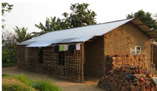
Véranda protégée du soleil et du vent par un écran végétal en bambou. © C. Belinga Nko'o- CRAterre
