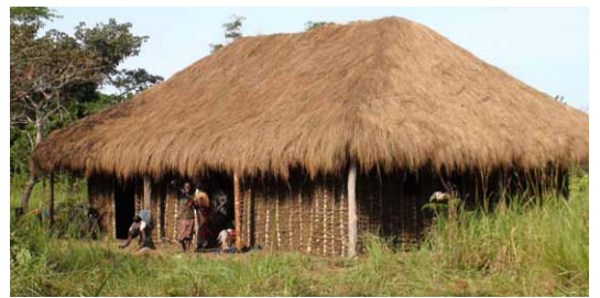
Construction à plan quadrangulaire (C3) avec des murs en torchis (M3) et toiture végétale en paille (Cv1) à 4 pans au Kasai-Oriental. © Angoulevant
