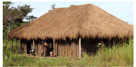
Construction à plan quadrangulaire (C3) avec des murs en torchis (M3) et toiture végétale en paille (Cv1) à 4 pans au Kasai-Oriental. © Angoulevant
