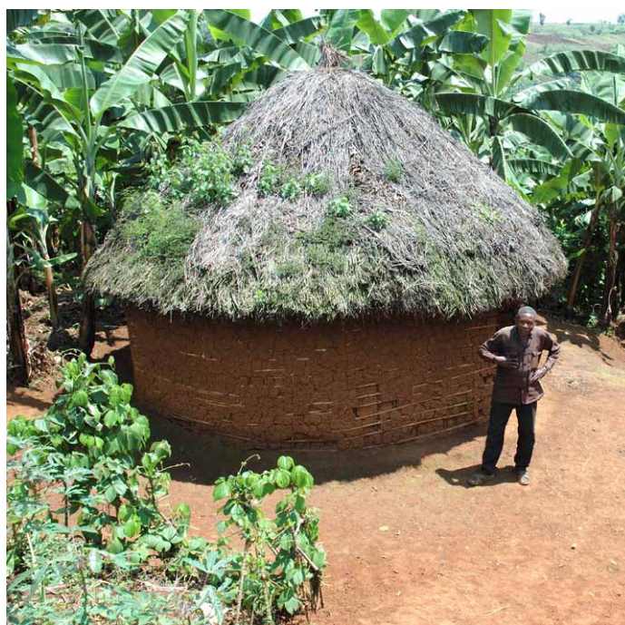
Maison à plan circulaire avec des murs en torchis et toiture végétale conique. Sud-Kivu. CC- Julien Harneis
