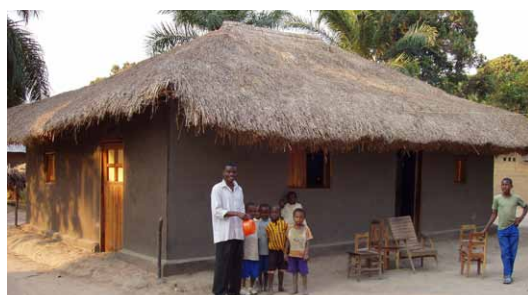
Maison près de Kabalo (Tanganyika) avec un enduit en terre récent. © CRAterre
