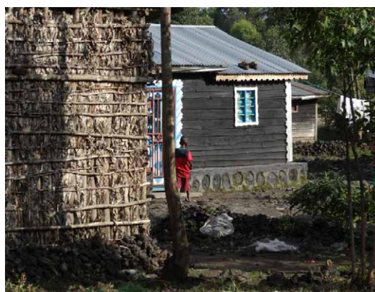
Maisons quadrangulaires (C3). Les deux maisons ont un soubassement en pierre. La première a des murs avec ossature bois et remplissage en feuilles (M2) et la deuxième est aussi en ossature bois avec remplissage et bardage en bois (F2). Toiture à deux pans en tôle (T2 et Cv3). Près de Goma, Nord-Kivu. © G. Paccoud- CRAterre
