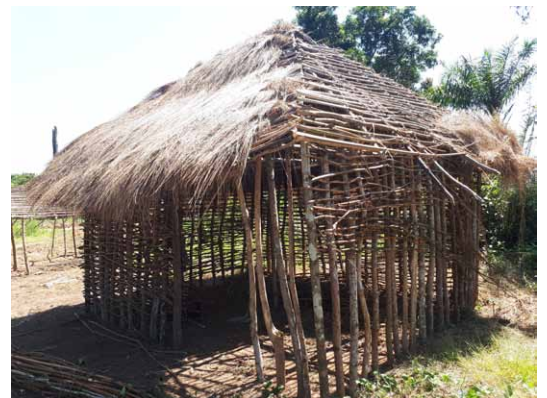
Maison en torchis en cours de construction. Mbulungu, Kasai-Central. © NRC
