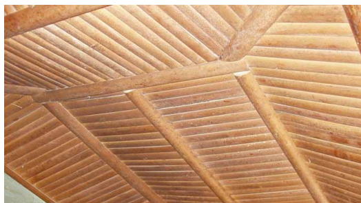
Faux-plafond de 20 ans construit en tiges de raphia près de Kabalo, Tanganyika. © O. Moles- CRAterre
