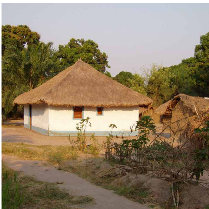
Maison en adobe avec finition à la chaux. Toiture en à quatre pans. Kabalo, Tanganyika. © O. Moles - CRAterre
