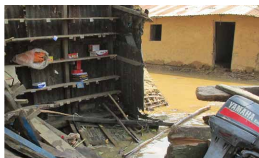
Exemple de construction ayant subi un séisme à Kabalo, Tanganyika. La structure des murs est gravement affectée, le bâtiment n'est plus sûr, un autre effort (séisme, inondation, cyclone) pourrait causer des dégâts définitifs. © CRAterre
