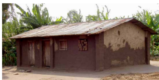
Maison en adobe avec des contreforts aussi en adobe et toiture à deux versants en tôle. Rutshuru, Nord-Kivu. © O. Moles - CRAterre
