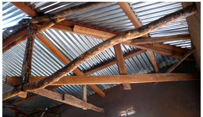
Vue intérieure de la charpente en bois et la couverture en tôle. © CRAterre
