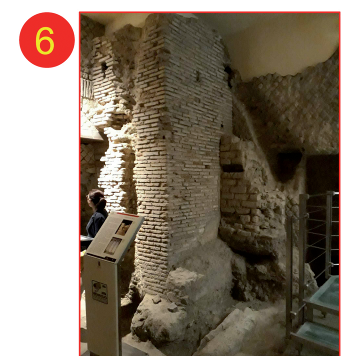
Realizzazione di un nuovo pilastro in laterizi
