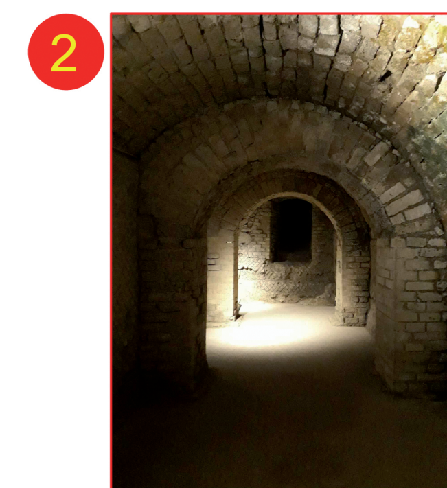
Archi di rinforzo della volta probabilmente finalizzati al consolidamento della struttura del criptoportico
