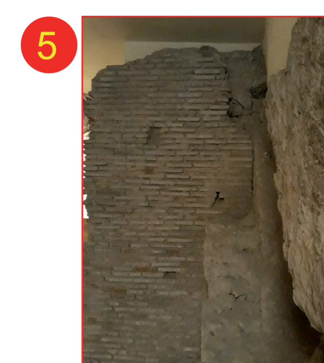
Ringrosso del muro mediante muratura in laterizio
