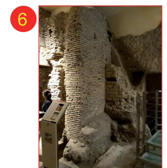
Realizzazione di un nuovo pilastro in laterizi
