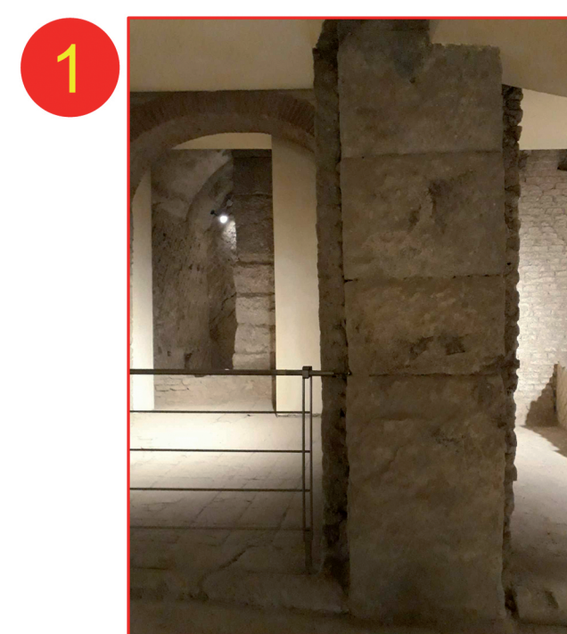
Ringrosso in laterizi probabilmente finalizzato a contrastare il meccanismo fuori dal piano della muratura
