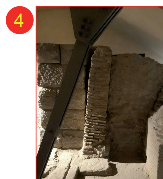
Realizzazione del muro lato est (a destra nella foto) probabilmente finalizzata a contrastare il meccanismo fuori dal piano della muratura in laterizio in direzione trasversale
