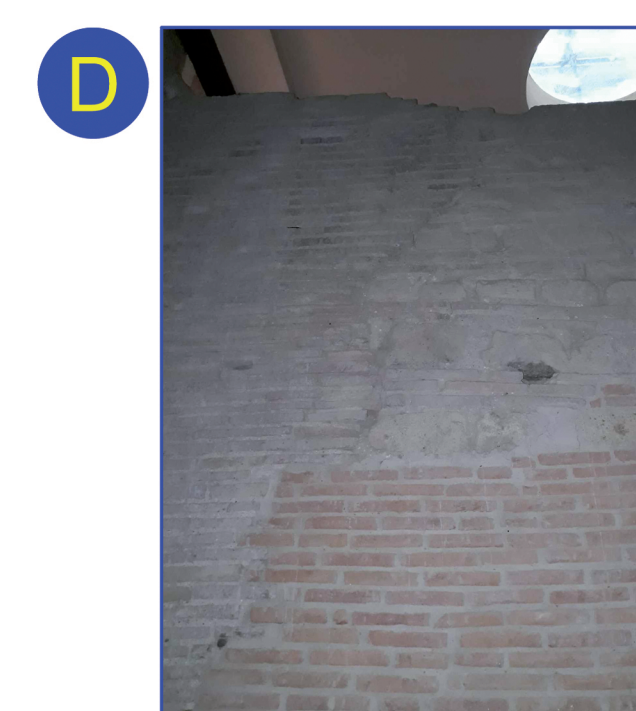
Rifacimento della parte alta della muratura con opera mista al di sopra di un intervento moderno in laterizi
