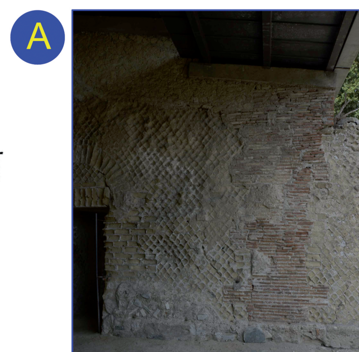
Riparazione di una lesione con muratura in laterizi
