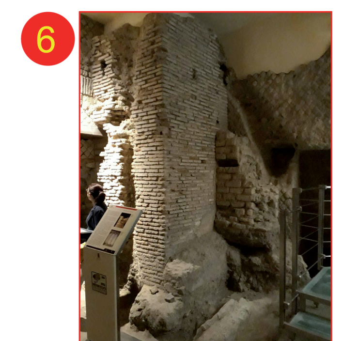
Realizzazione di un nuovo pilastro in laterizi
