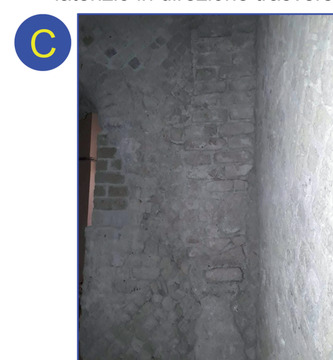
Ricostruzione parziale dell'incrocio murario nella parte alta in blocchetti di tufo all'interno della muratura in opera reticolata
