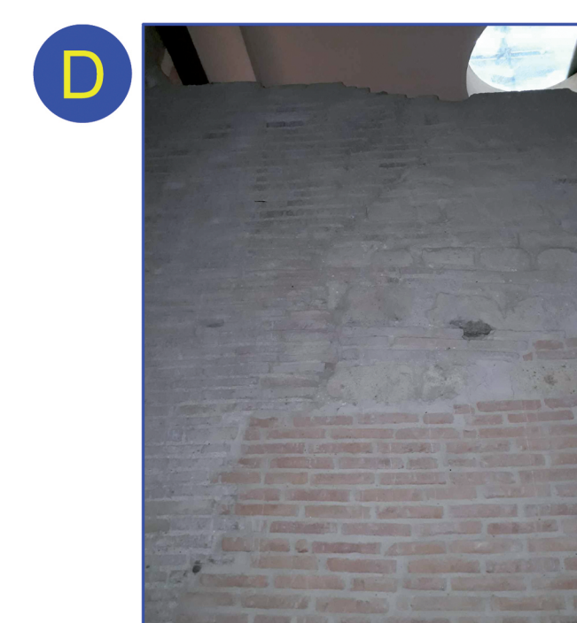
Rifacimento della parte alta della muratura con opera mista al di sopra di un intervento moderno in laterizi
