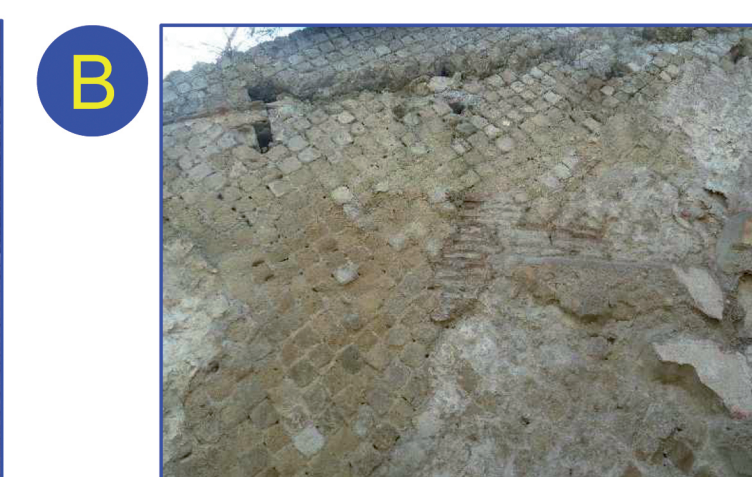
Riparazione di una lesione con muratura in laterizi
