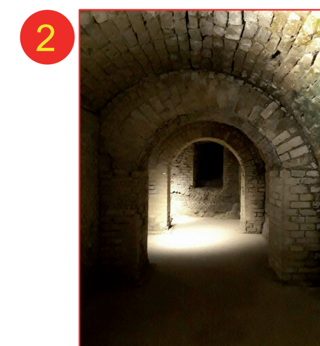
Archi di rinforzo della volta probabilmente finalizzati al consolidamento della struttura del criptoportico
