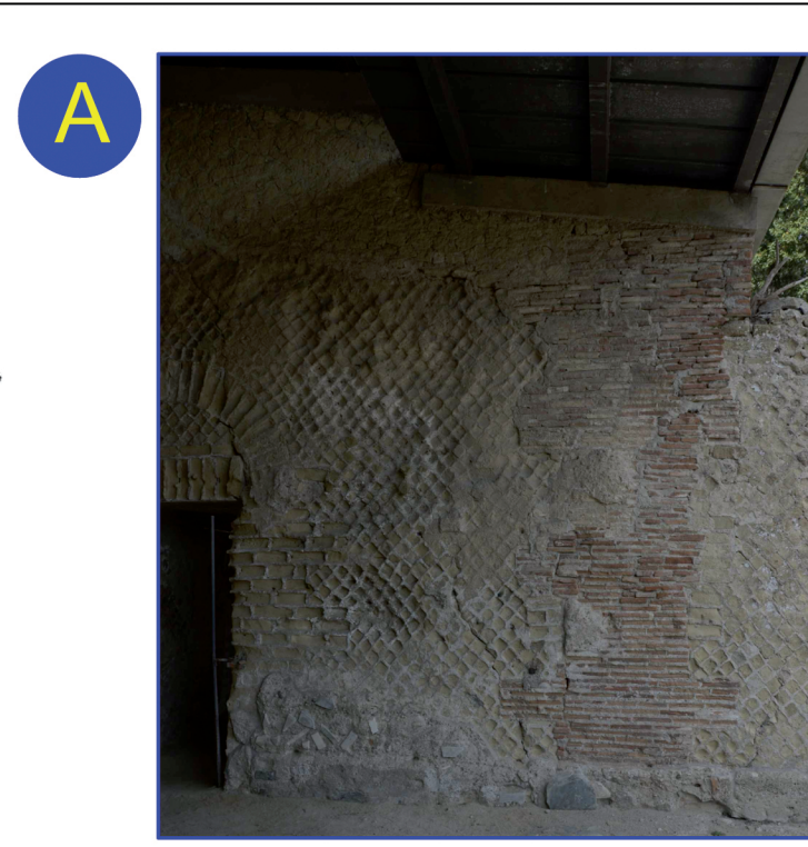
Riparazione di una lesione con muratura in laterizi
