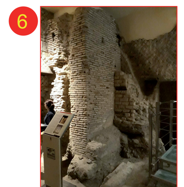
Realizzazione di un nuovo pilastro in laterizi
