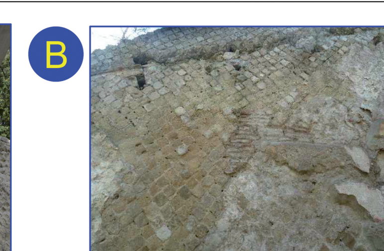
Riparazione di una lesione con muratura in laterizi
