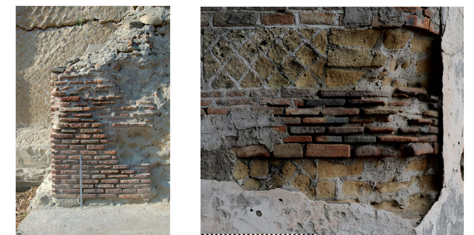
Fig. 7 – Particolare del piedritto nord del fornice D50e del paramento sud-ovest del mausoleo G70.
