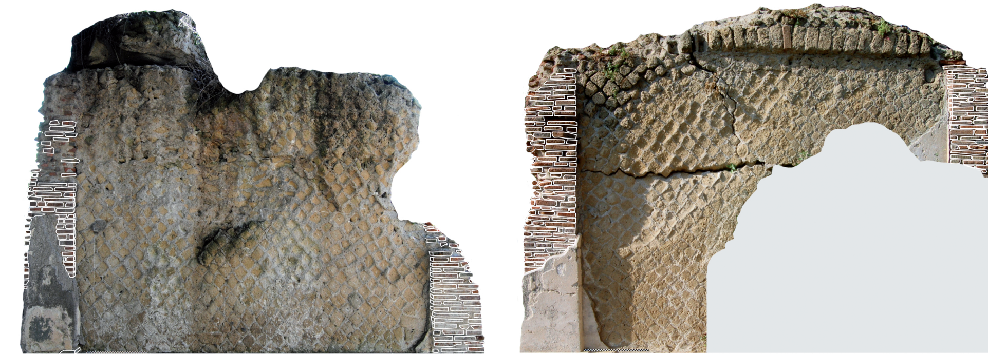
Fig. 2 – Fotopiani con rilievo dei particolari in tegole fratte del paramento nord e sud.
