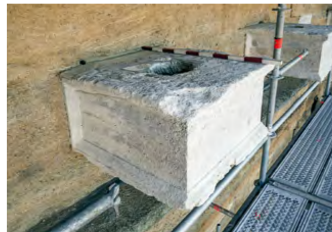
Fig. 172 – ORANGE, PCR « Architecture, technique et décor du théâtre antique ». Une console basse en calcaire blanc destinée à recevoir un mât de velum (cliché A. Badie).
