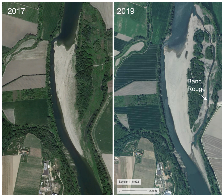
Figure 2 – Le bras du Banc Rouge avant (2017) et après (2019) les travaux de réhabilitation.
